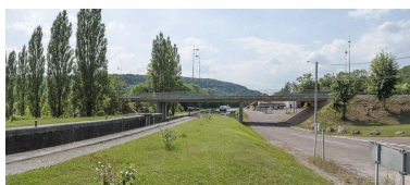
Vue d'ensemble. Phot. Pierre-Marie Barbe-Richaud IVR26_20122101941NUC4AQ
