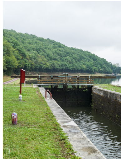
Vue du sas. Phot. Pierre-Marie Barbe-Richaud IVR26_20175800272NUC2A
