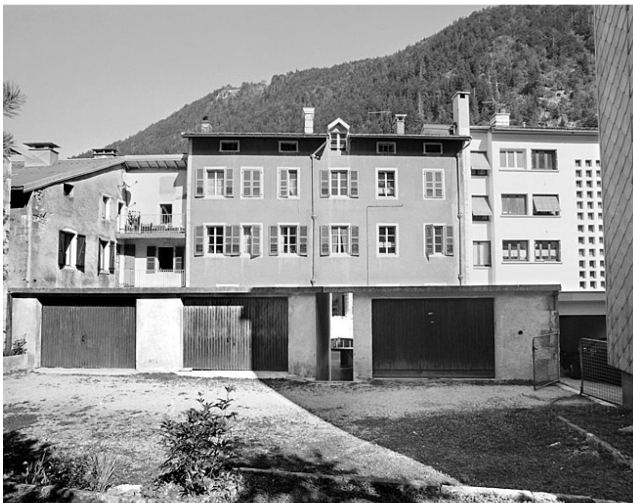
Elévation postérieure et garages.
