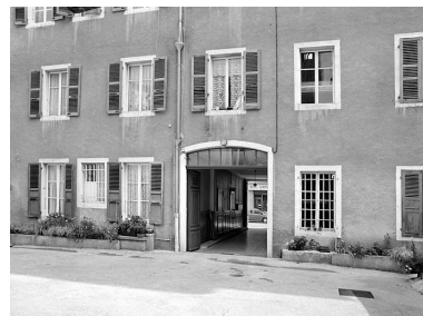
Rez-de-chaussée et premier étage de l'élévation postérieure. Phot. Yves Sancey IVR43_20033900402X
