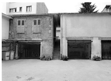
Elévation antérieure des garages. Phot. Yves Sancey IVR43_20033900404X
