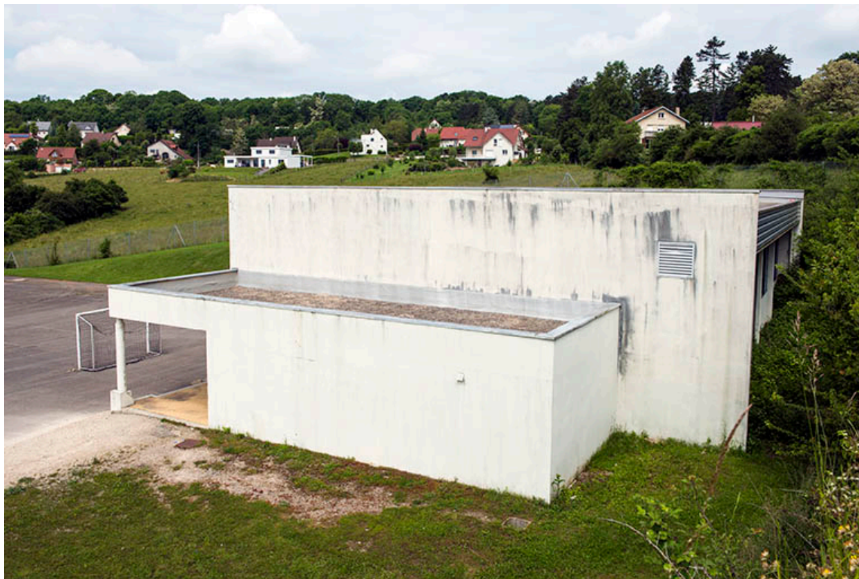
Angle sud-est du gymnase.
