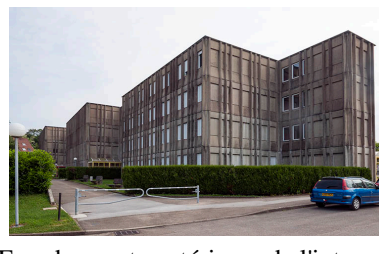
Façade ouest postérieure de l'internat.
