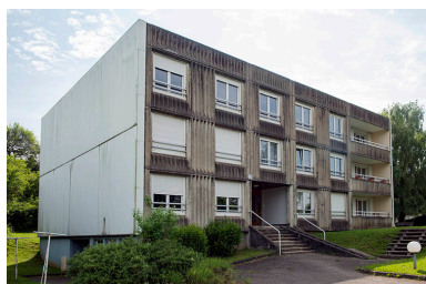
Angle ouest des logements de fonction. Phot. Mary Ruffinoni IVR43_20132500733NUC4A
