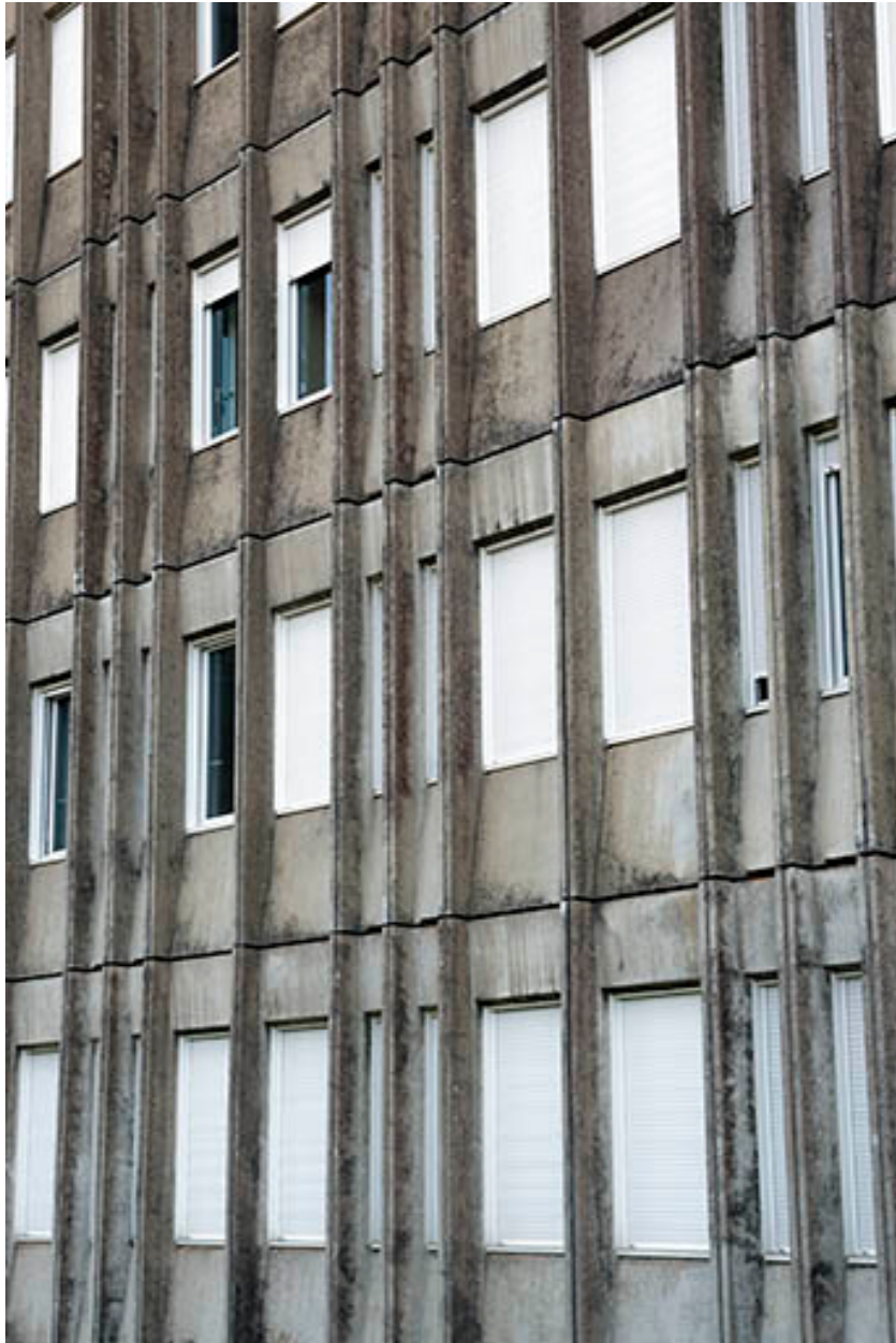
Détail de la façade de l'internat.
