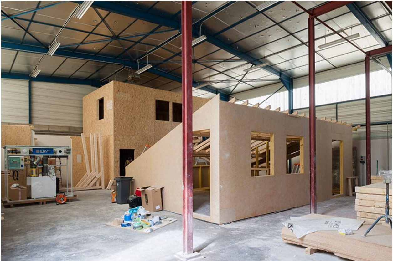
Espaces d'apprentissage des techniques de menuiserie.
