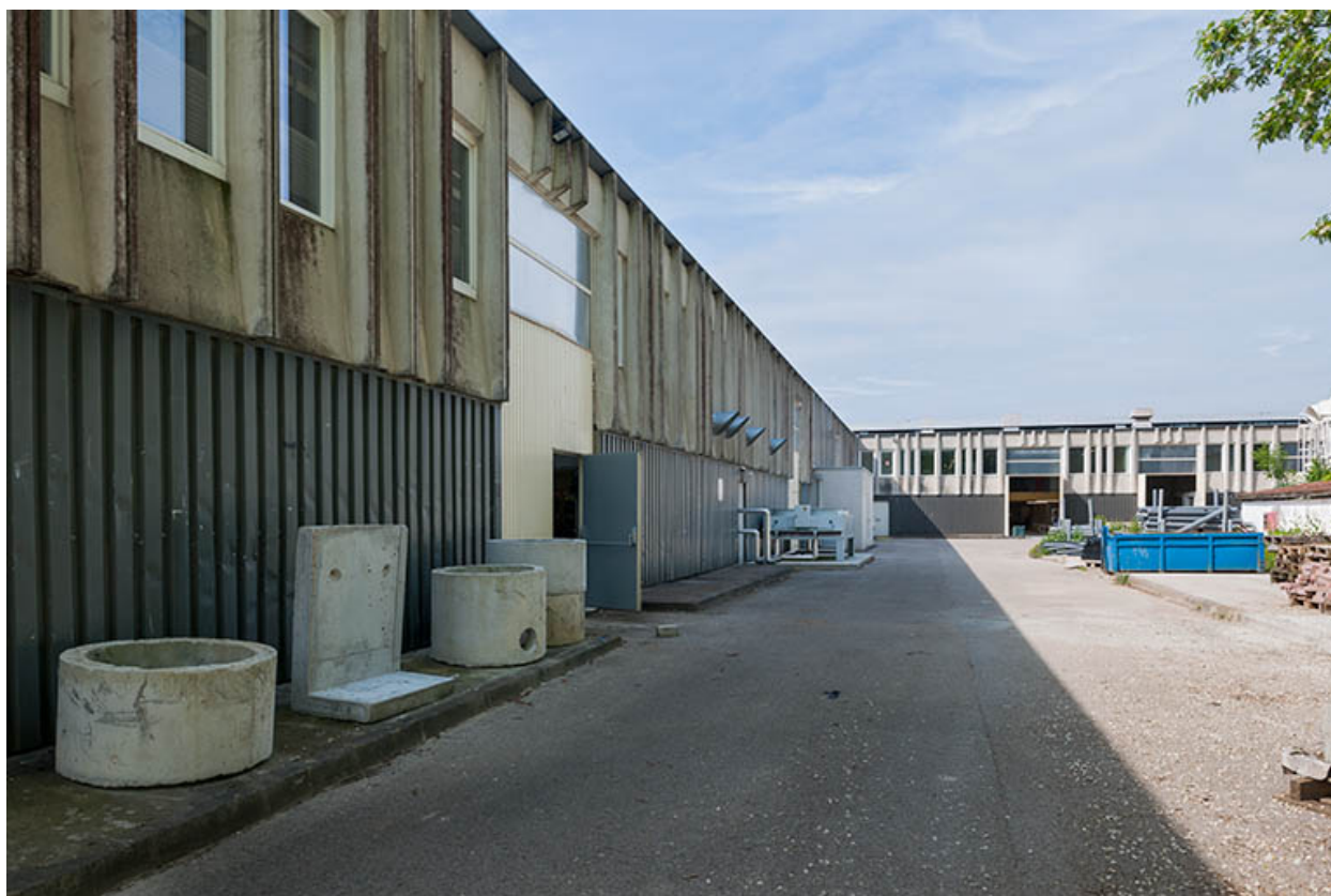
Façade postérieure nord-ouest de l'aile nord-est de l'externat depuis le nord-est.
