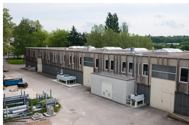
Face postérieure nord-ouest de l'aile nord-est de l'externat depuis le sud.
