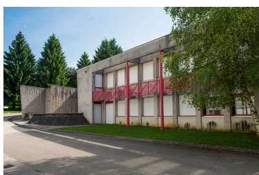
Façade ouest de l'aile occidentale de l'externat.
