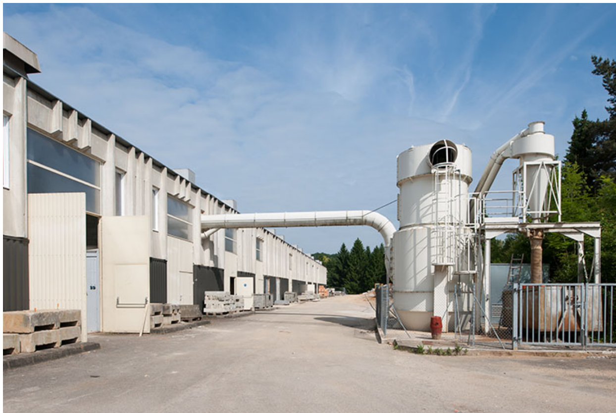
Façade postérieure nord-est de l'externat depuis l'est.
