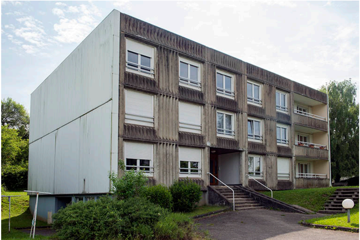
Angle ouest des logements de fonction.
