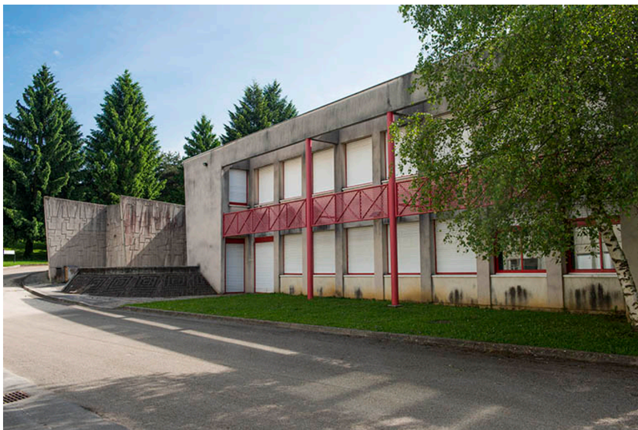
Façade ouest de l'aile occidentale de l'externat.
