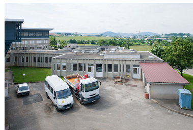
Façade postérieure nord de la cantine et vue sur l'externat surélevé.
