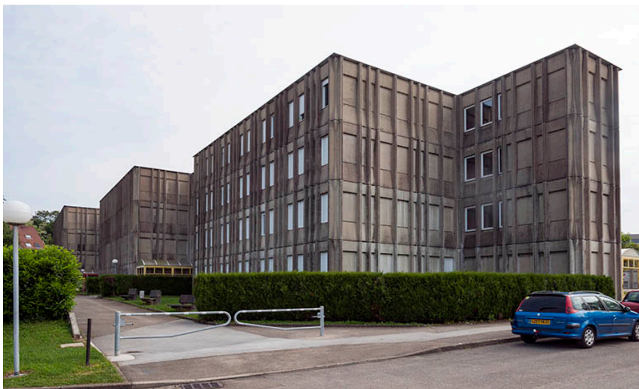
Façade ouest postérieure de l'internat.
