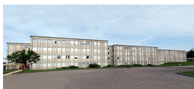
Façade est antérieure de l'internat. Phot. Mary Ruffinoni IVR43_20132500738NUC4A
