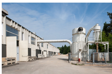
Façade postérieure nord-est de l'externat depuis l'est.
