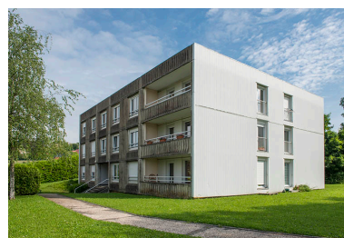
Angle sud des logements de fonction. Phot. Mary Ruffinoni IVR43_20132500732NUC4A
