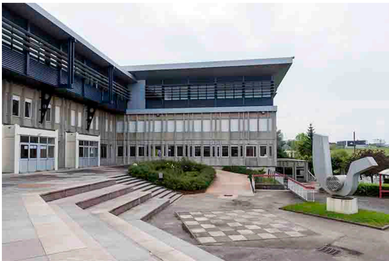
Vue d'ensemble : entrée, cour, externat surélevé, sculpture.
