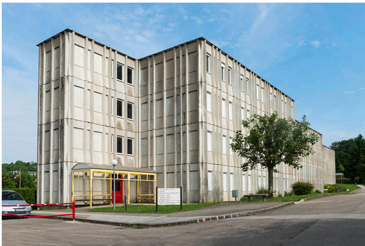
Pignon sud et façade est antérieure de l'internat.
