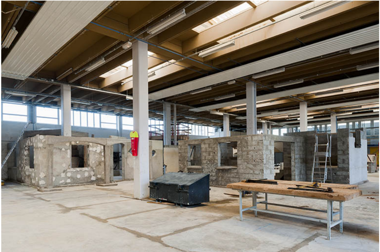
Espaces d'apprentissage des techniques de construction de gros oeuvre.
