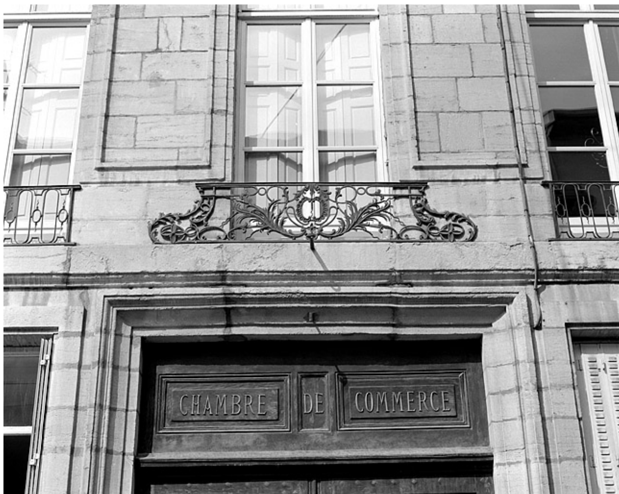
Façade antérieure, garde-corps de la fenêtre centrale.
