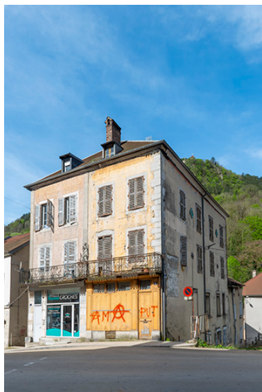
Vue d'ensemble depuis l'est. Phot. Jérôme Mongreville
