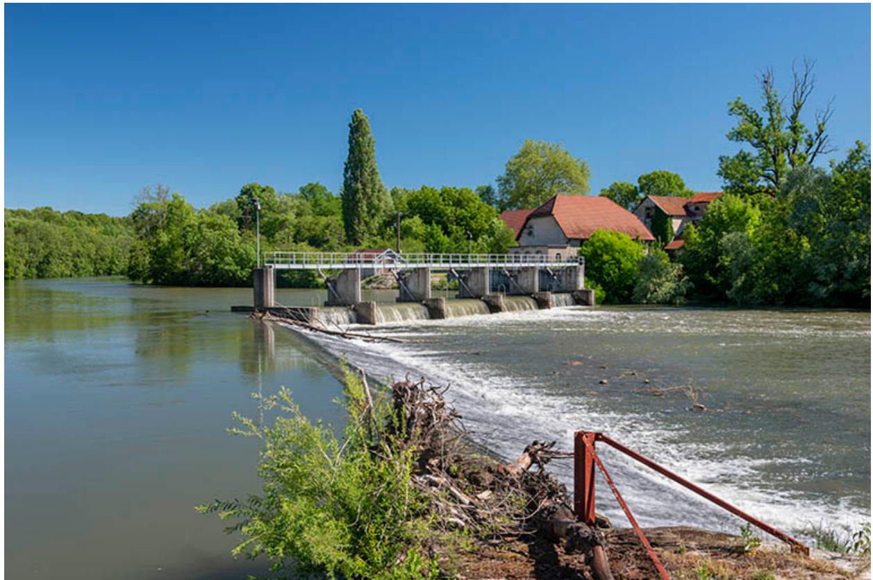
Site du barrage.
