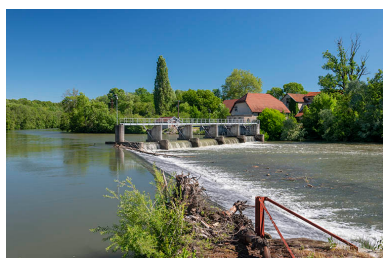
Site du barrage. Phot. Jérôme Mongreville IVR43_20197000353NUC4A
