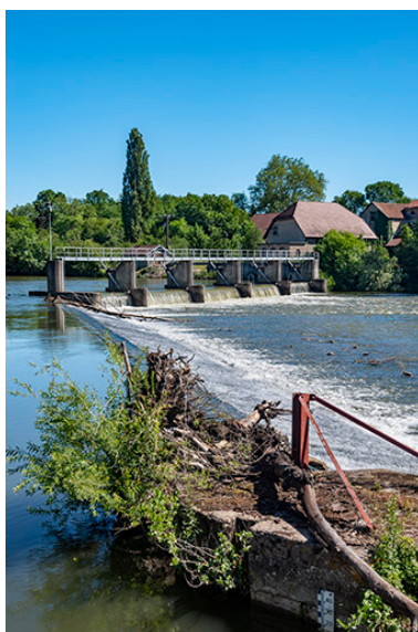
Culée du barrage. Phot. Jérôme Mongreville
