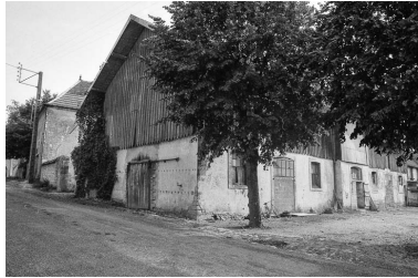
Les dépendances perpendiculaires à la rue. Phot. Bernard Lardière IVR43_19797000230Z
