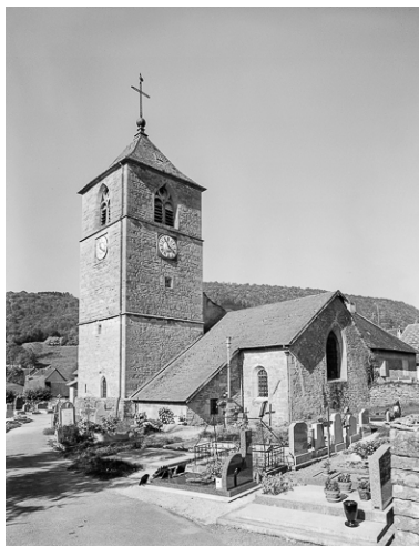
Extérieur : façade latérale droite et chevet en 1978. Phot. Yves Sancey IVR43_19783900061V
