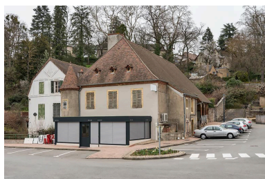
Vue actuelle depuis le sud-ouest. Phot. Pierre-Marie Barbe-Richaud IVR26_20227100040NUC4A
