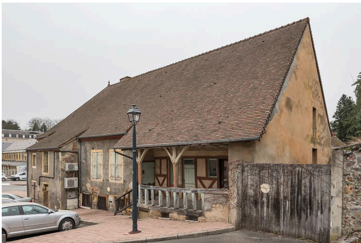
Vue actuelle depuis l'ouest.
