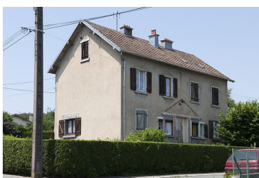
Maison jumelée à entrées opposées. Phot. Jérôme Mongreville IVR43_20122501765NUC4A
