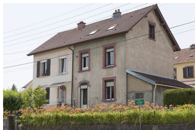
Maison jumelée à entrées contiguës. Phot. Jérôme Mongreville IVR43_20122501771NUC4A
