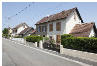
Maisons jumelées. Phot. Jérôme Mongreville IVR43_20122501767NUC4A
