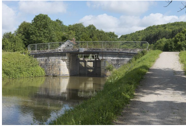
Vue d'ensemble du pont sur écluse.
