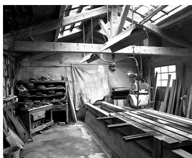
Débiteuse-mouleuse sud : vue d'ensemble. Phot. Yves Sancey IVR43_19933900344X
