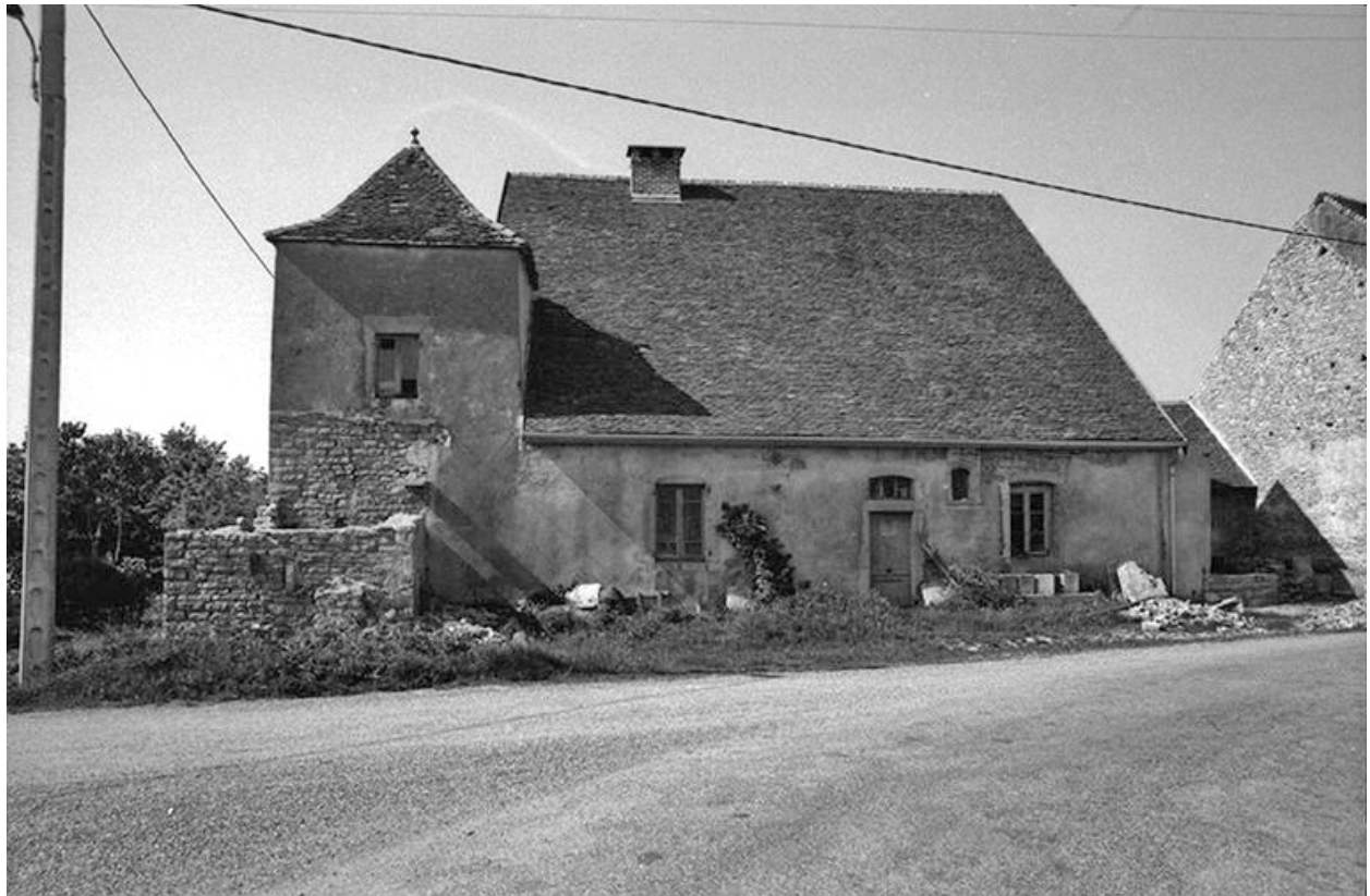
Ferme située le long du chemin départemental n° 208 du Pin à Lons-le-Saunier.
