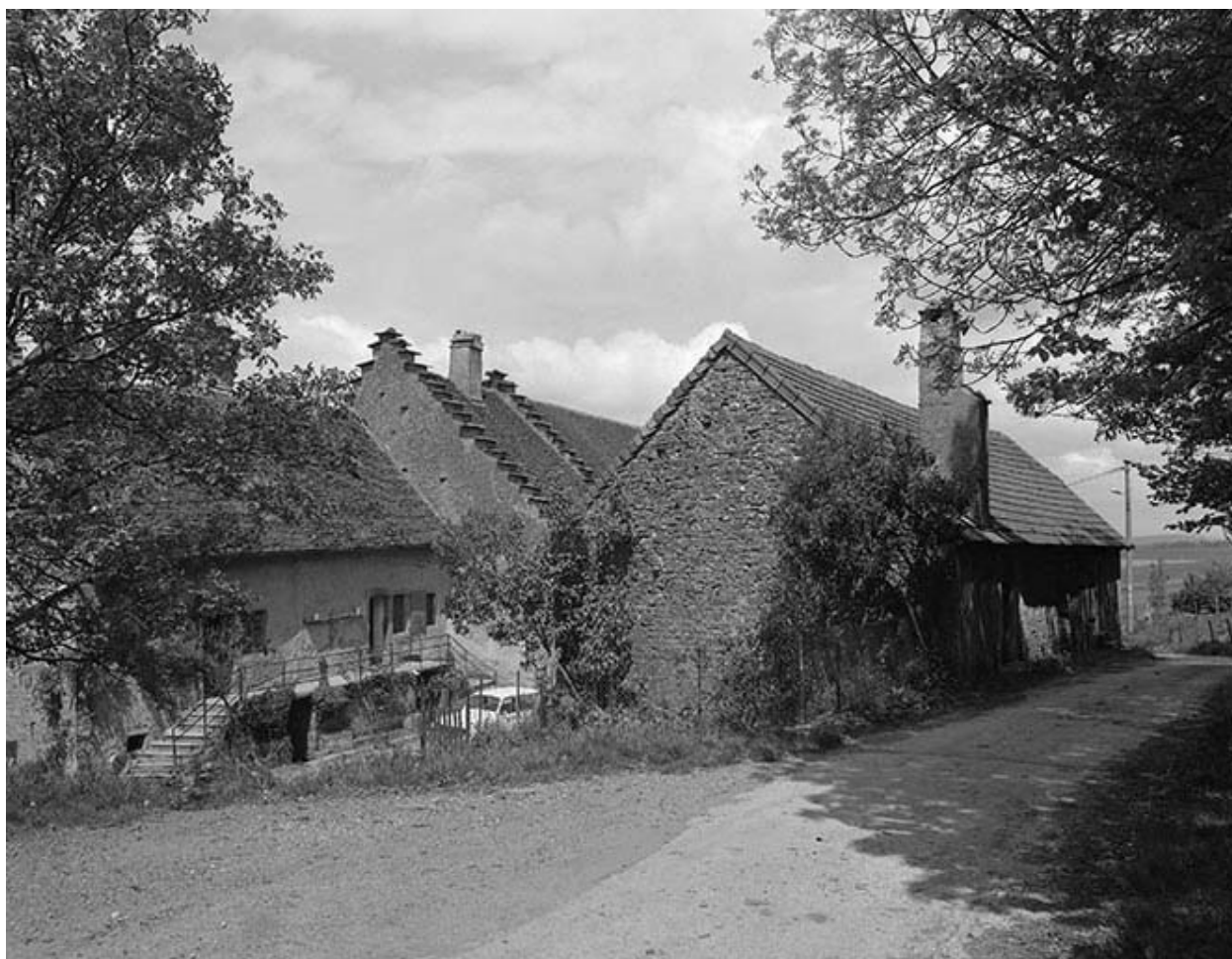
Ferme située chemin du Château.
