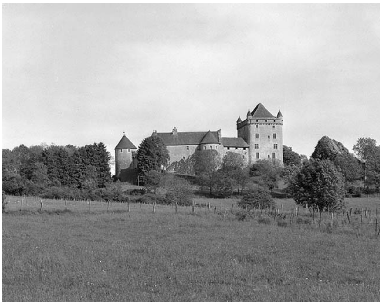
Le château : façade ouest.
