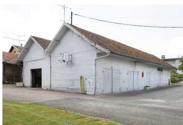
Dépendances. Phot. Jérôme Mongreville IVR43_20097000449NUC2A
