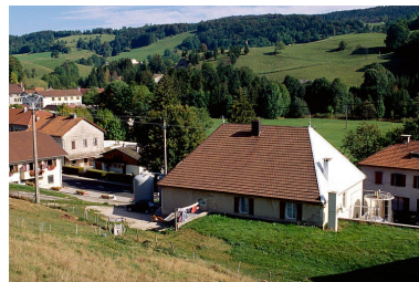
Façade postérieure. Phot. Yves Sancey IVR43_19973901196ZA
