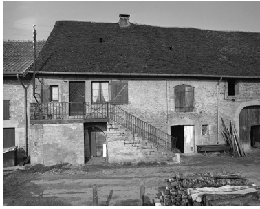
Façade antérieure : l'habitation. Phot. Jérôme Mongreville IVR43_19853900081X
