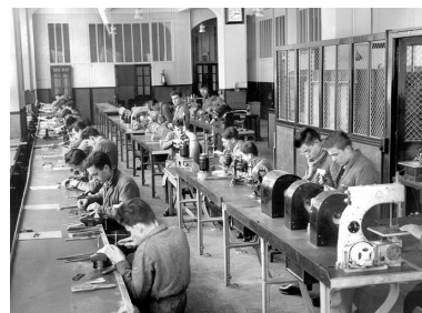
[La fabrication des montures en plastique], 1965. Scies à chantourner au premier plan, machines à polir à côté. Phot. Yves Sancey IVR43_20103900702NUC2A
