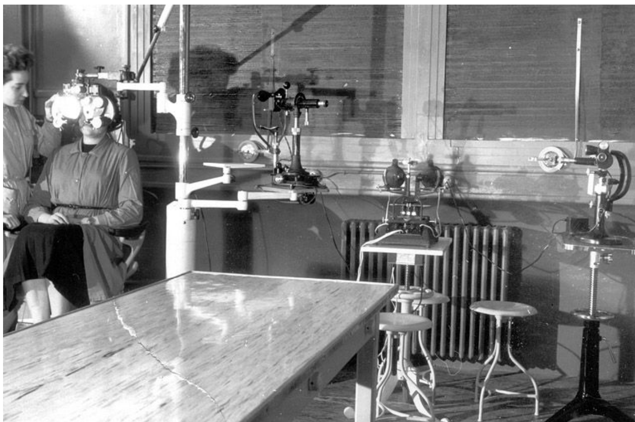
[Salle de " prise de vue " : mesure de la vision au réfracteur], 3e quart 20e siècle. Appareils inutilisés, de gauche à droite : réfracteur, synoptophore et lampe à fente (permettant l'observation des tissus internes de l'oeil).
