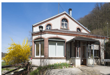
Pignon sud. Vestibule. Phot. Jérôme Mongreville IVR43_20132500169NUC4A
