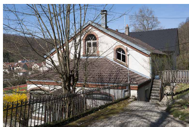
Pignon sud vu de trois quarts. Phot. Jérôme Mongreville IVR43_20132500167NUC4A
