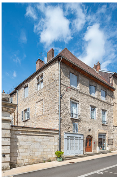
Vue d'ensemble de trois quarts gauche. Phot. Jérôme Mongreville IVR43_20233900187NUC4A
