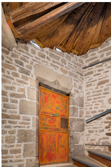
Escalier en vis (entrée n°1 cour des Halles). Porte palière. Phot. Jérôme Mongreville IVR43_20233900092NUC4A
