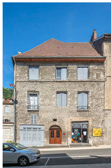
Bâtiment sud. Vue de face. Phot. Jérôme Mongreville IVR43_20233900867NUC4A
