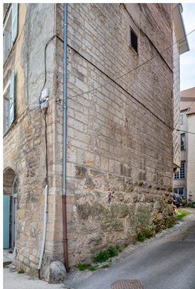
Façade nord du n°17. Phot. Jérôme Mongreville IVR43_20243900562NUC4A
