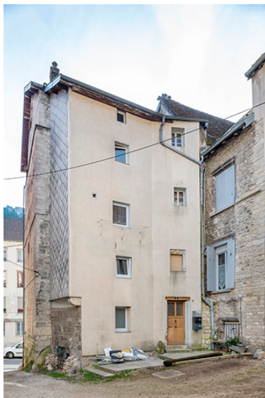
Façades postérieures des deux maisons depuis la cour des Halles. Phot. Jérôme Mongreville IVR43_20233900087NUC4A
