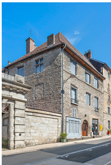
Vue de trois quarts gauche. Phot. Jérôme Mongreville IVR43_20233900868NUC4A
