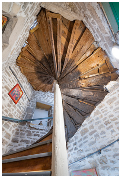
Escalier en vis (entrée n°1 cour des Halles). Vue en contre-plongée. Phot. Jérôme Mongreville IVR43_20233900091NUC4A
