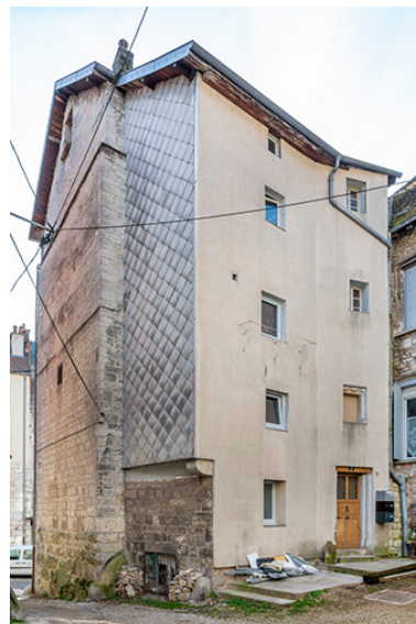
Façade postérieure (n°17) depuis la cour des Halles. Phot. Jérôme Mongreville IVR43_20233900086NUC4A
