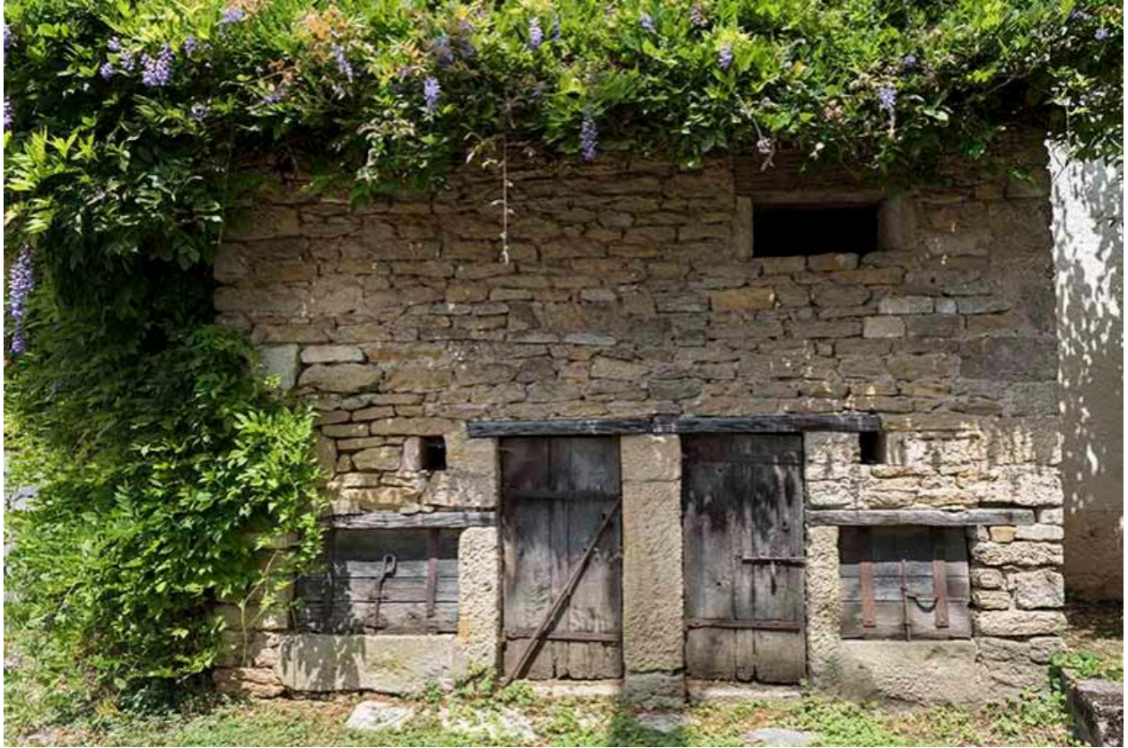
Soue à cochons située rue de la Barque, contre le mur pignon de la maison située 1 Grande rue
