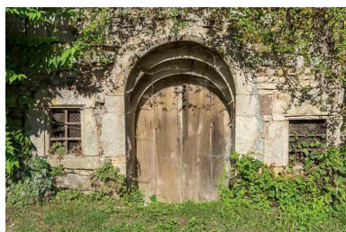
Entrée de cave sur rue Phot. Sonia Dourlot IVR43_20167001119NUC4A
