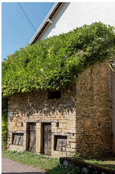
Soue à cochons située rue de la Barque Phot. Sonia Dourlot IVR43_20167001333NUC4A
