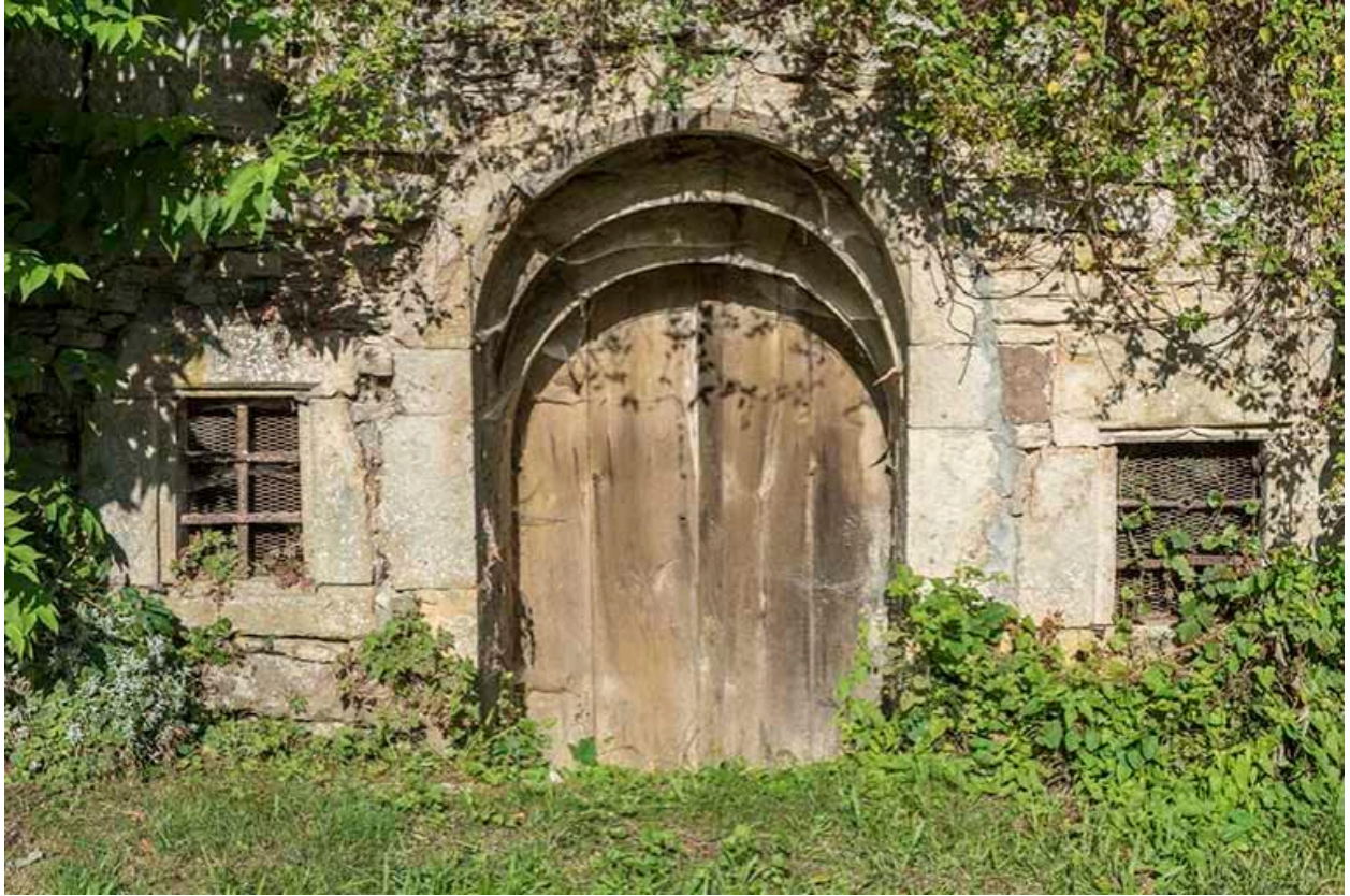
Entrée de cave sur rue
