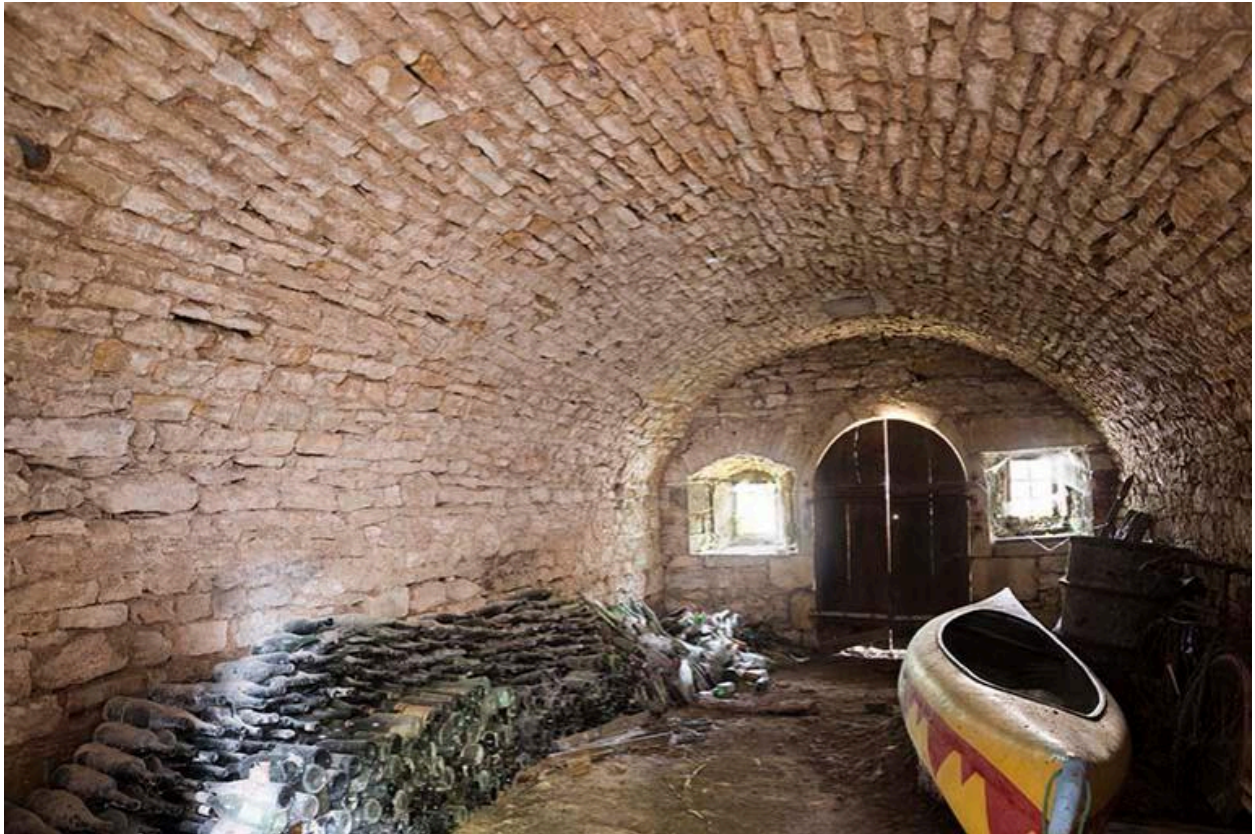
Vue intérieure de la cave ouvrant sur la rue
