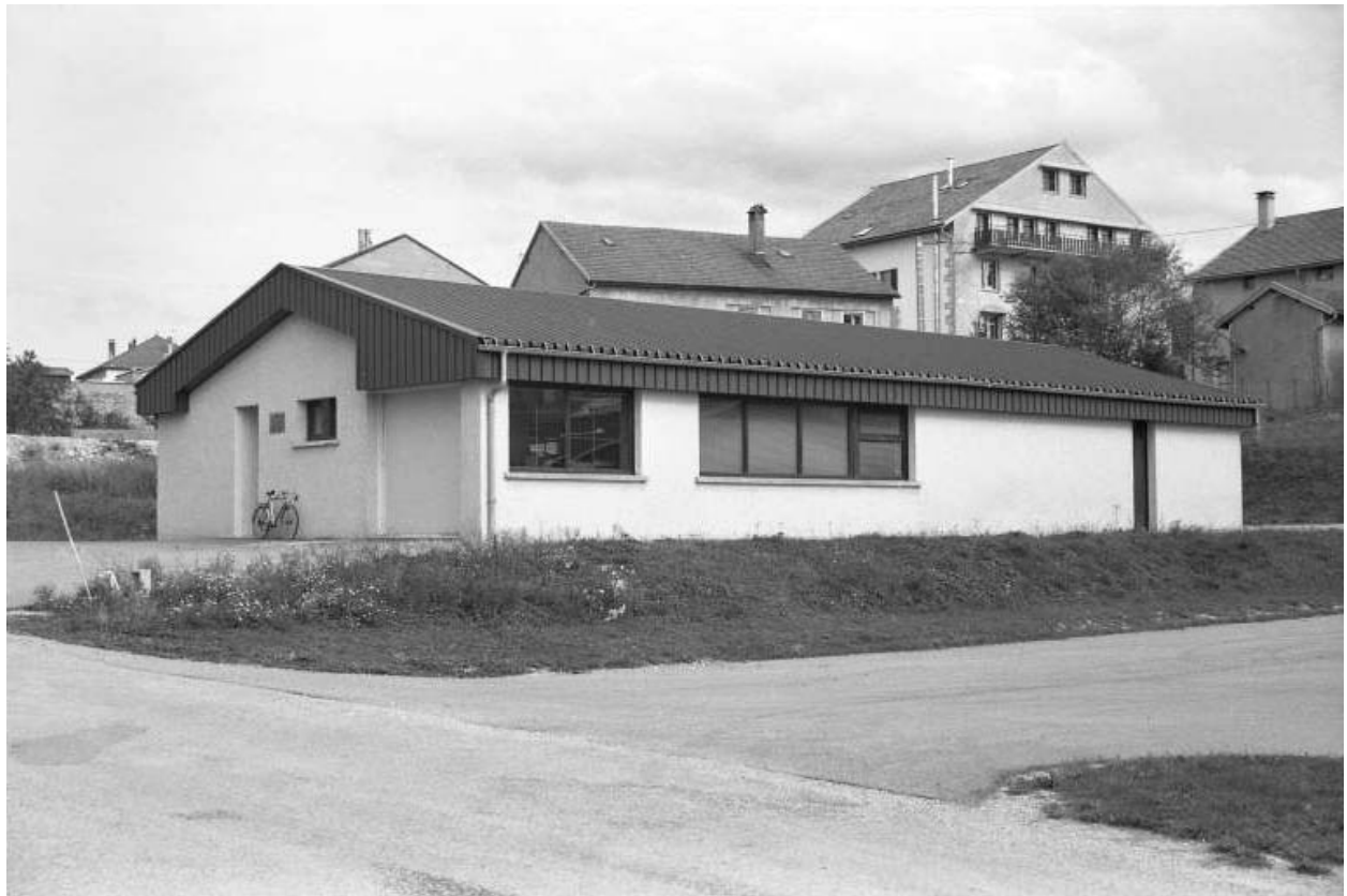
La nouvelle usine (rue Lacuzon).
