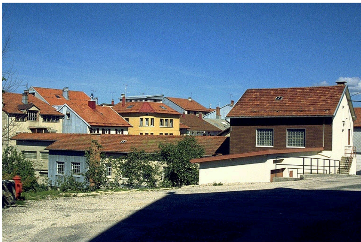
Façade postérieure de l'usine.
