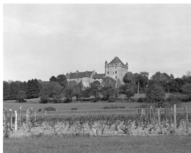
Façade ouest : vue éloignée. Phot. Yves Sancey IVR43_19813900240X
