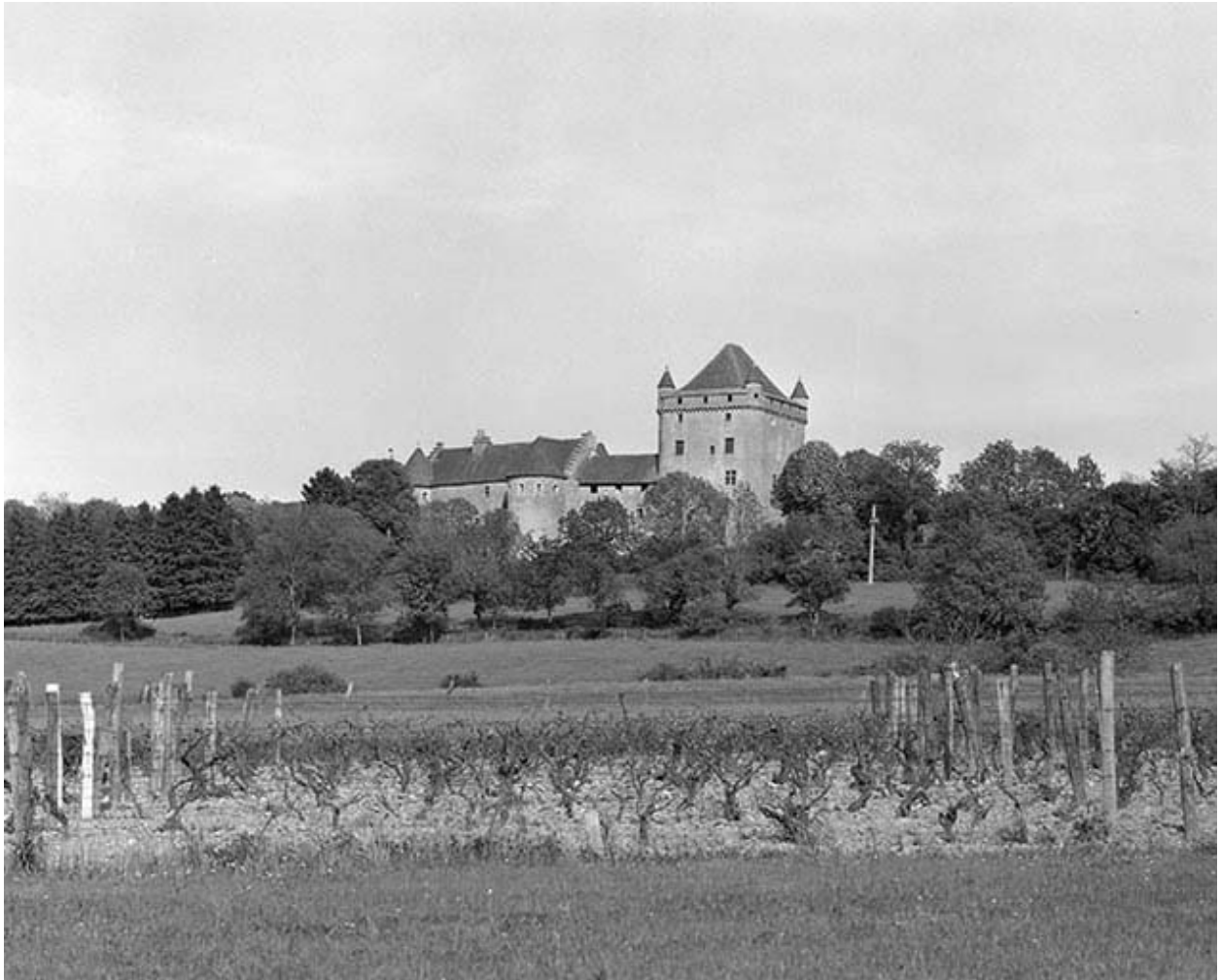
Façade ouest : vue éloignée.
