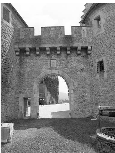
Portail nord : vue de face. Phot. Yves Sancey IVR43_19813900244X
