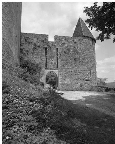
Portail sud. Phot. Yves Sancey IVR43_19813900243X
