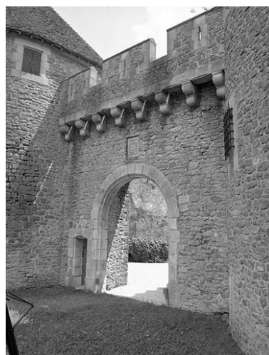
Portail nord : vue de trois quarts. Phot. Yves Sancey IVR43_19813900245X
