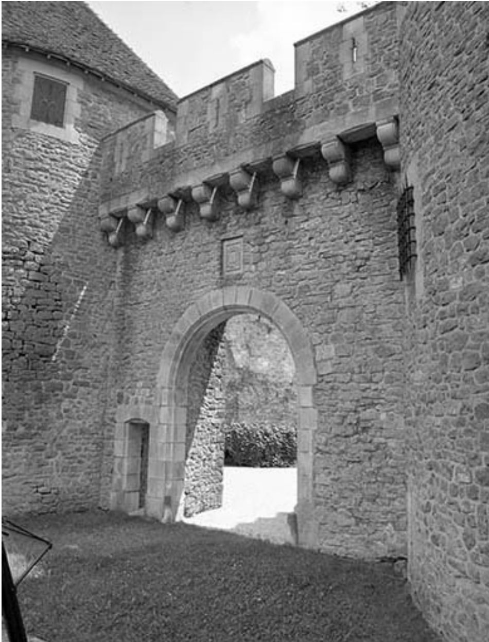
Portail nord : vue de trois quarts.
