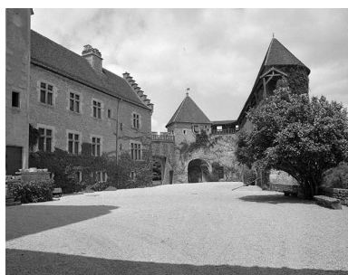
Vue générale de la cour intérieure. Phot. Yves Sancey IVR43_19813900241X
