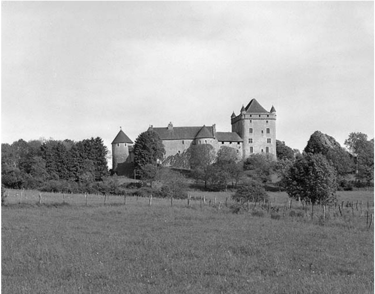
Façade ouest : vue éloignée.
