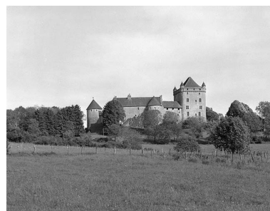
Façade ouest : vue éloignée. Phot. Yves Sancey IVR43_19813900239X
