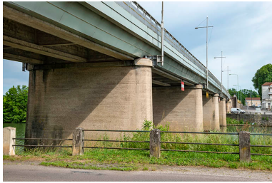
Vue de détail des piles du pont. Phot. Jérôme Mongreville IVR43_20197000380NUC4A
