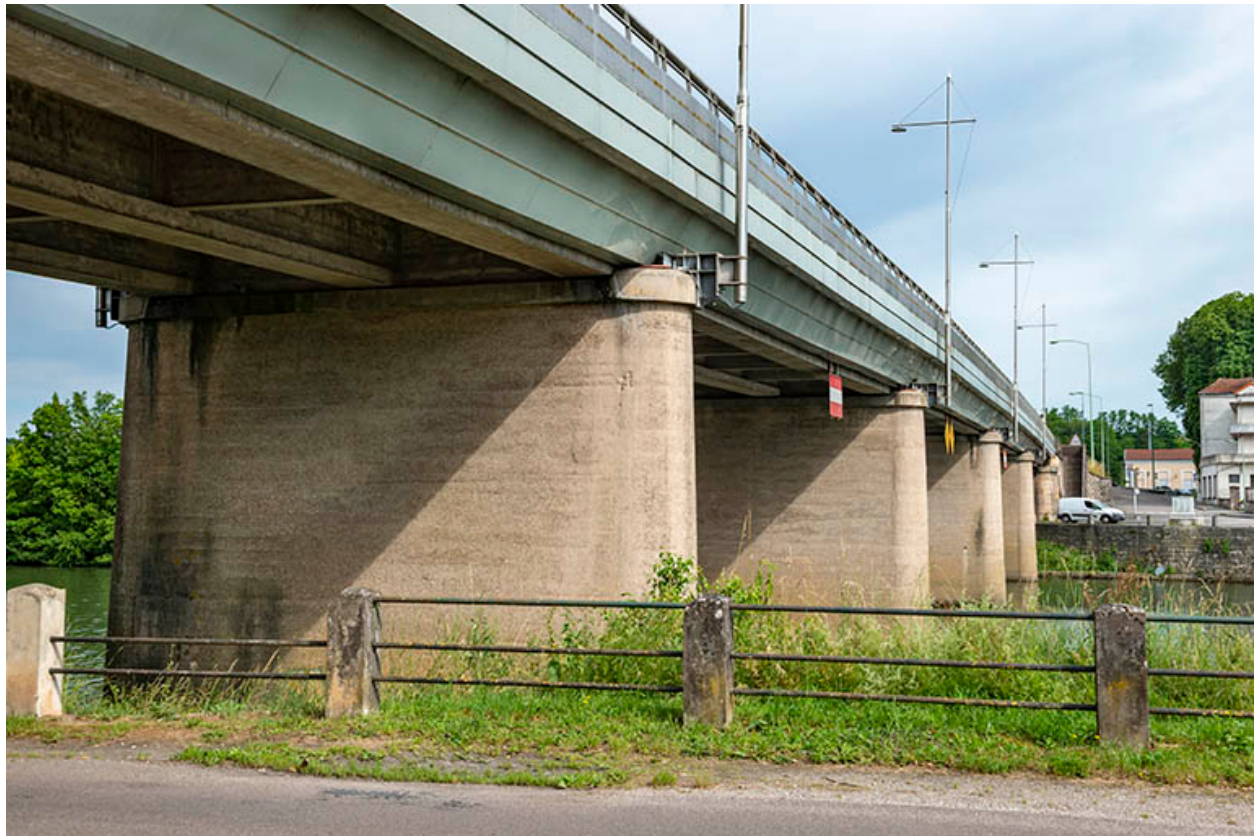
Vue de détail des piles du pont.
