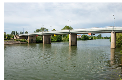
Le pont, vue actuelle. Phot. Jérôme Mongreville IVR43_20197000375NUC4A
