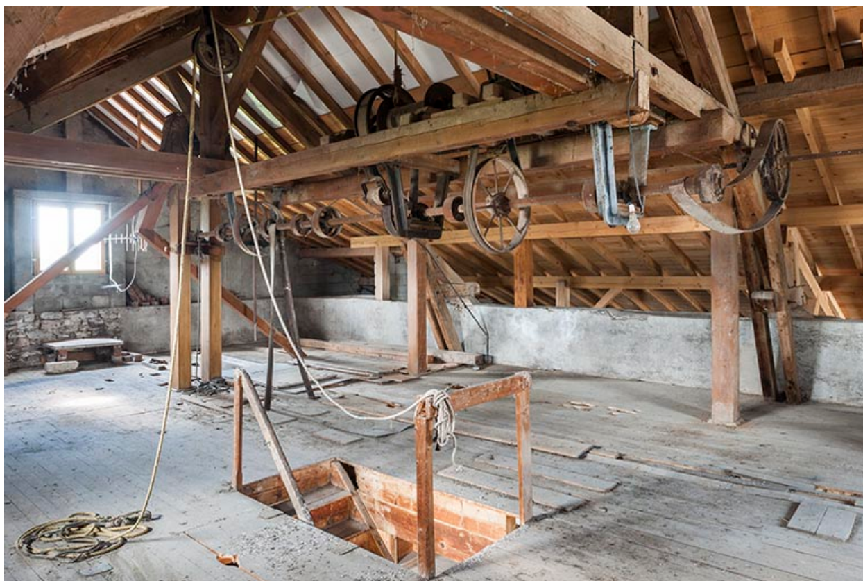
Etage en surcroît. Vue d'ensemble.
