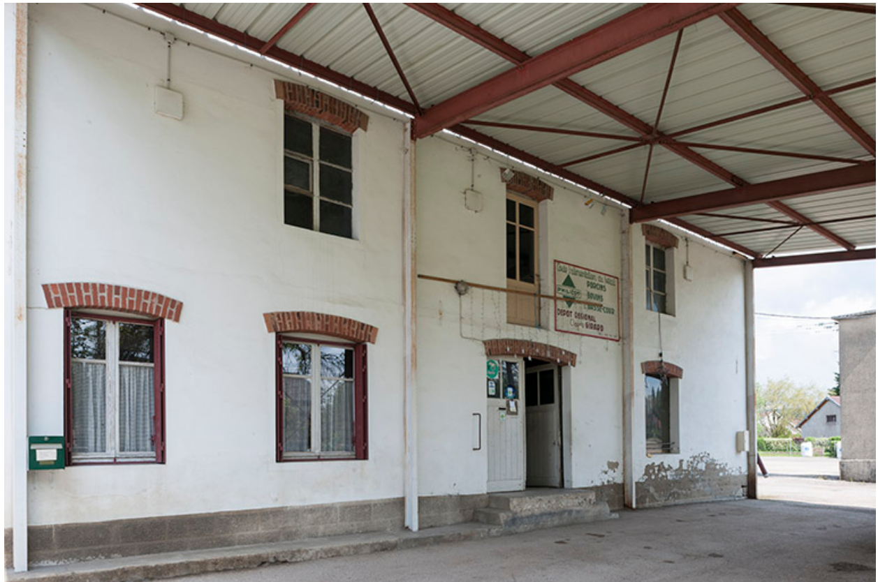
Façade est de la minoterie.
