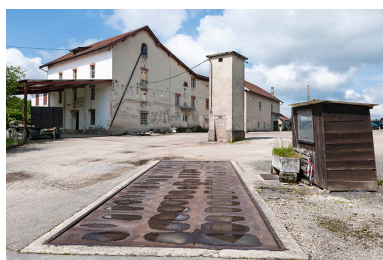
Vue d'ensemble depuis le pont bascule. Phot. Jérôme Mongreville IVR43_20162500389NUC4A
