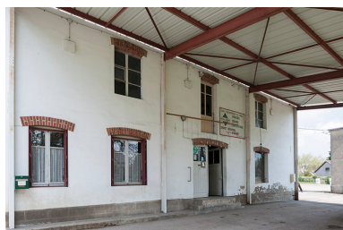
Façade est de la minoterie.
