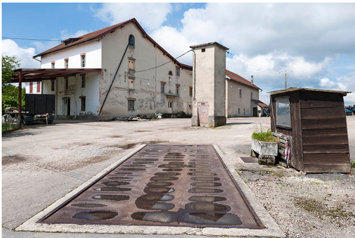
Vue d'ensemble depuis le pont bascule.
