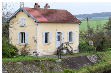
Vue de trois-quarts de la maison de la porte de garde depuis le sud-est. Phot. Sonia Dourlot IVR43_20157001501NUC2A
