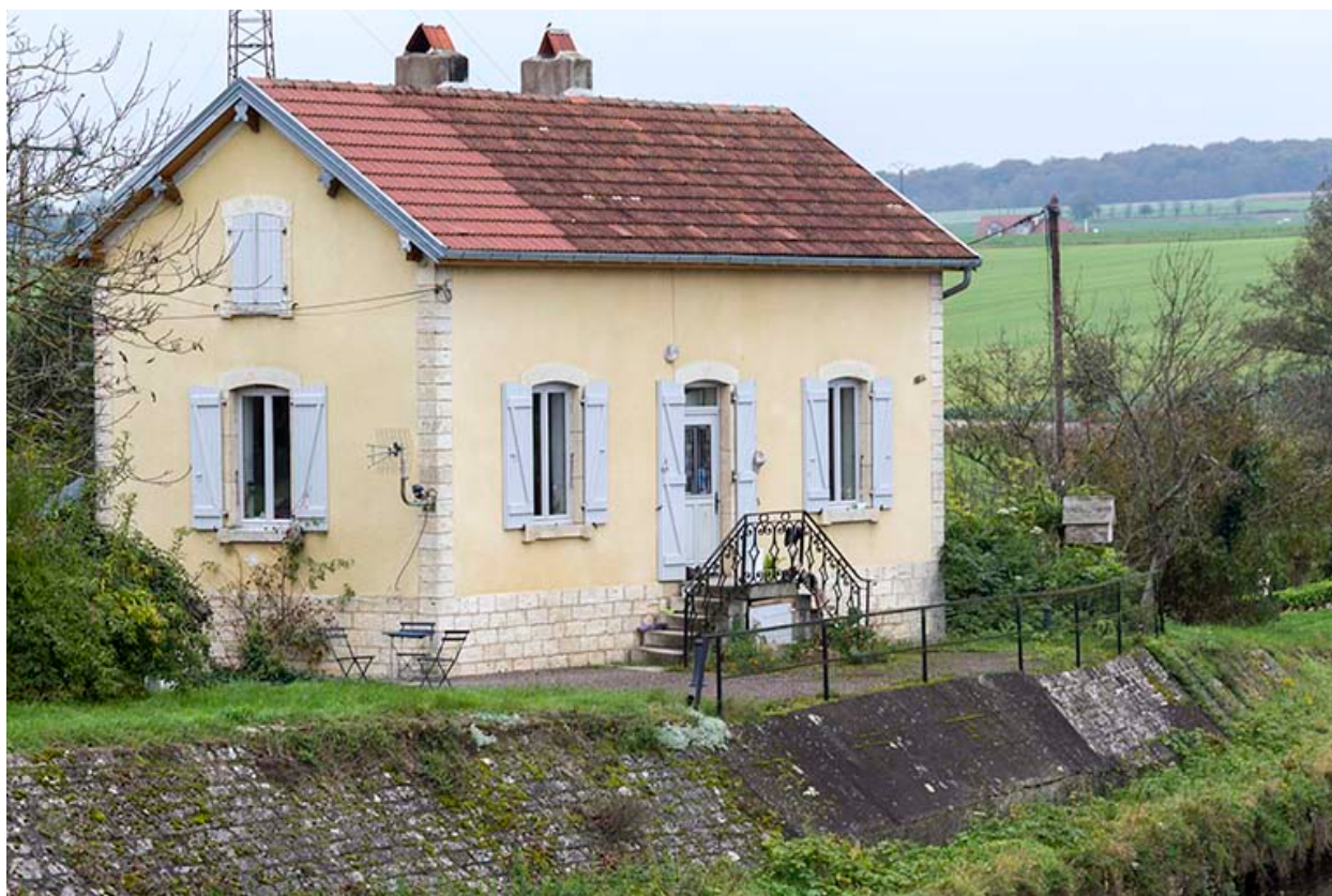
Vue de trois-quarts de la maison de la porte de garde depuis le sud-est.
