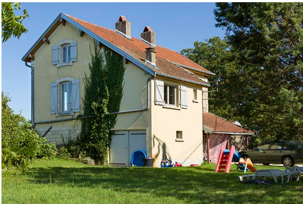
Vue de trois-quarts de la maison de la porte de garde depuis le nord-ouest.
