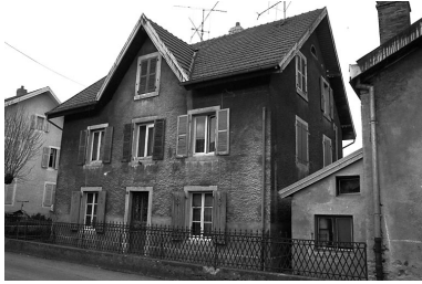
Vue d'ensemble. Phot. Bernard Lardière IVR43_19832500232Z
