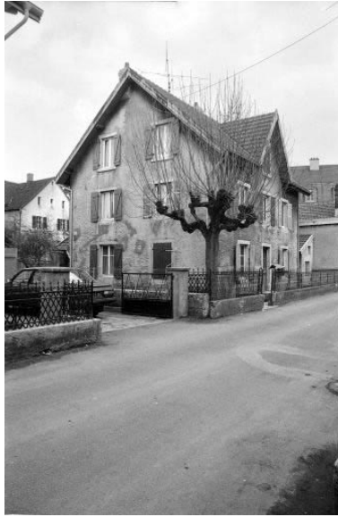
Vue de trois quarts gauche. Phot. Bernard Lardière IVR43_19832500231Z
