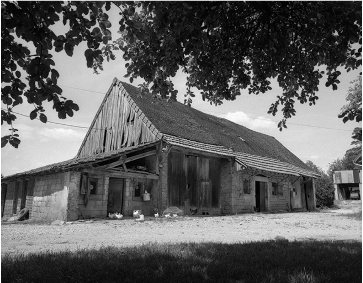
Partie agricole d'une ferme.
