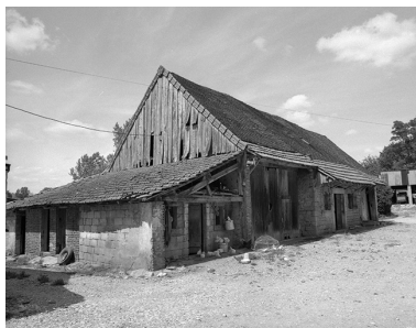
Partie agricole d'une ferme.
