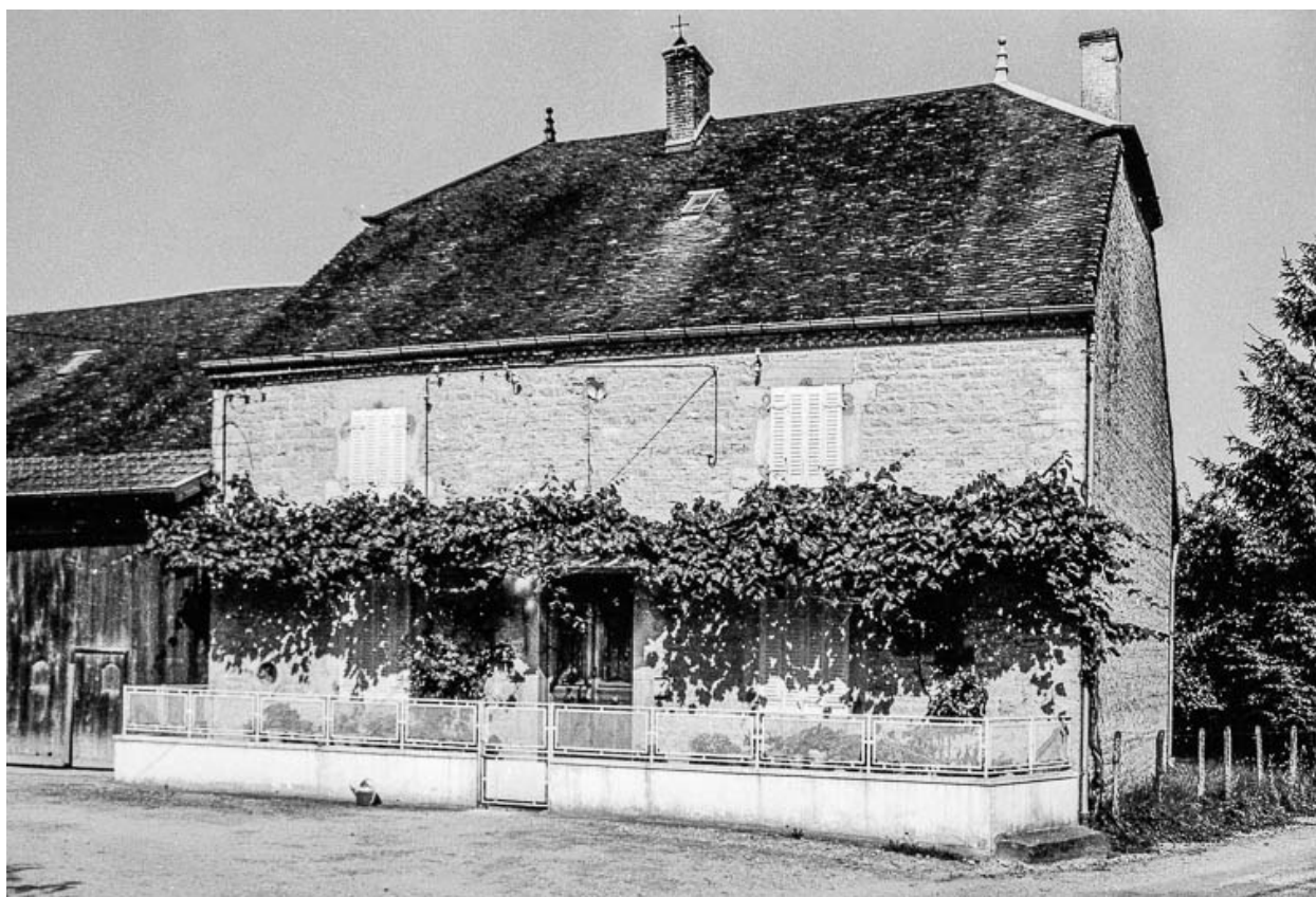
Ferme cadastrée 1811 D1 : façade antérieure de l'habitation.
