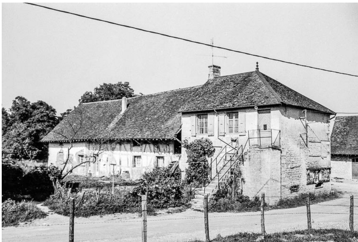
Ferme cadastrée 1811 D1 : façades antérieure et latérale droite.
