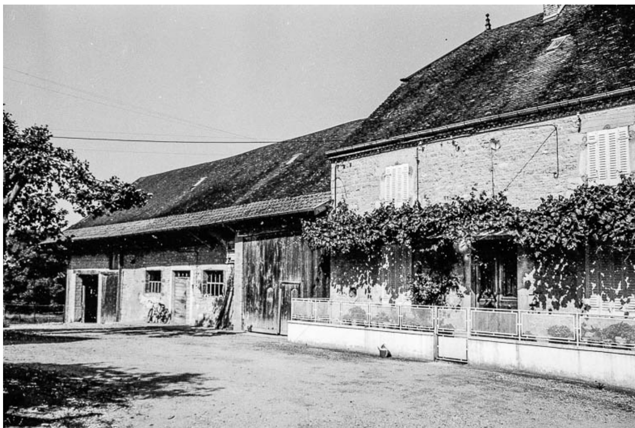
Ferme cadastrée 1811 D1 : façade antérieure de l'habitation et partie agricole.
