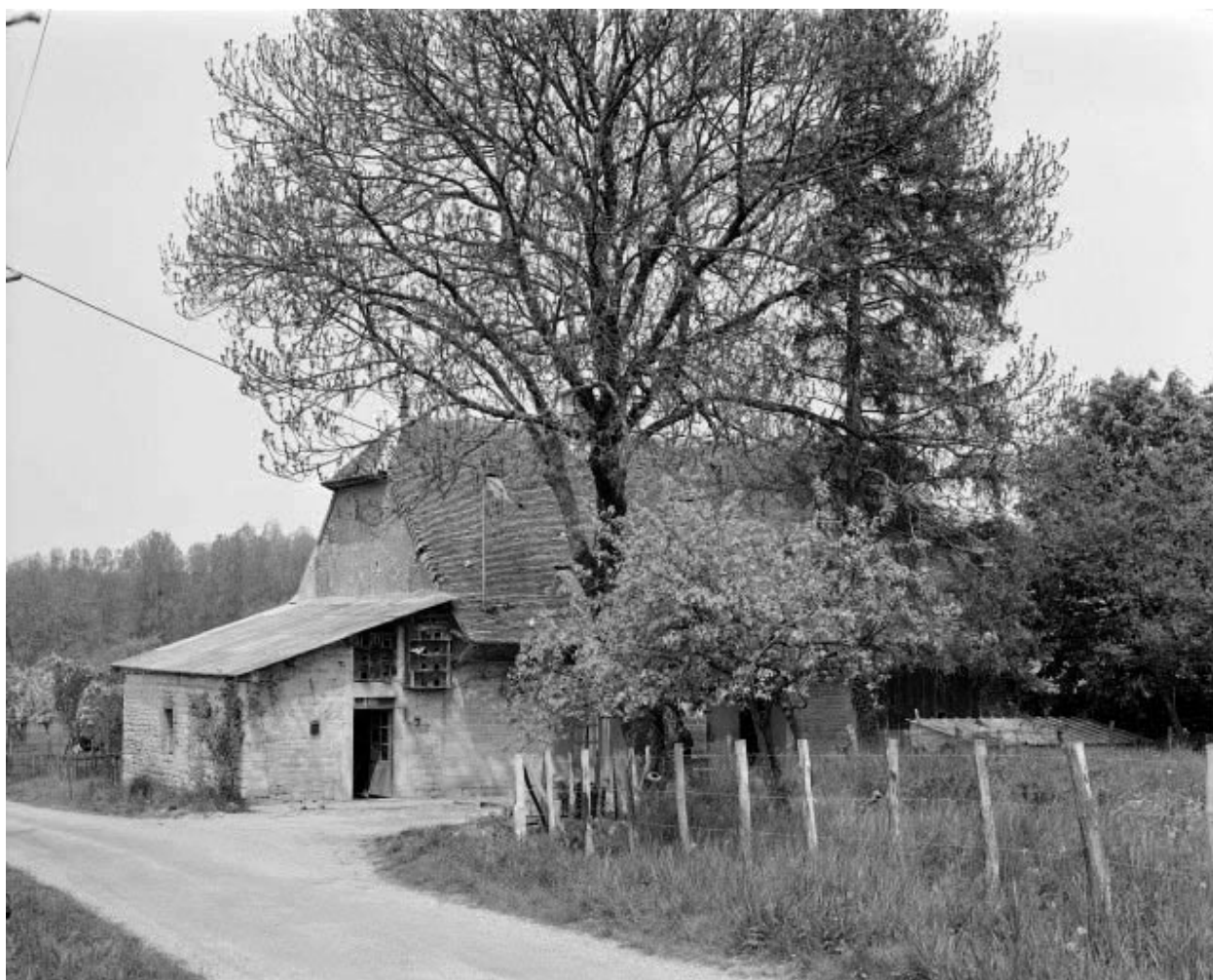
Ferme située 32 rue des Maquisards : vue d'ensemble.
