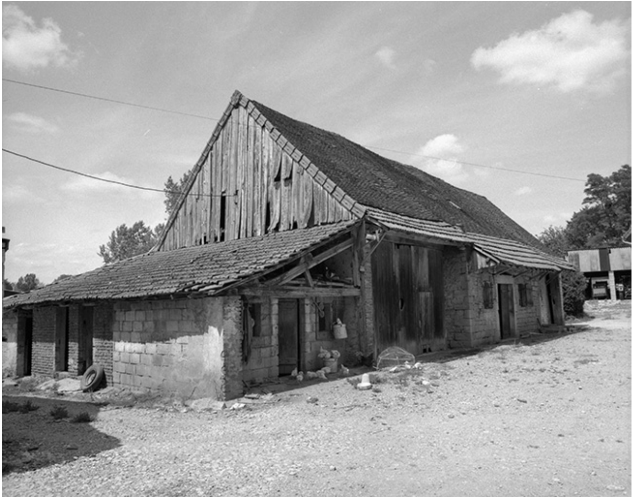
Partie agricole d'une ferme.
