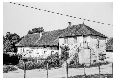
Ferme cadastrée 1811 D1 : façades antérieure et latérale droite. Phot. Guy Forestier IVR43_19753900323Z
