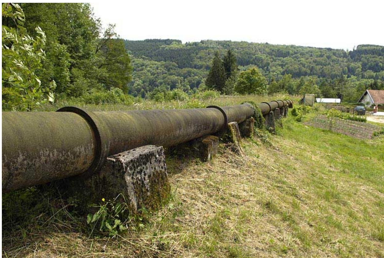
Détail de la conduite forcée.
