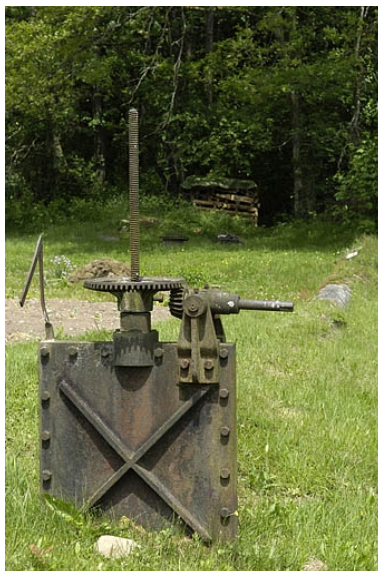
Vannage de la conduite forcée. Phot. Jérôme Mongreville IVR43_20057000325NUCA
