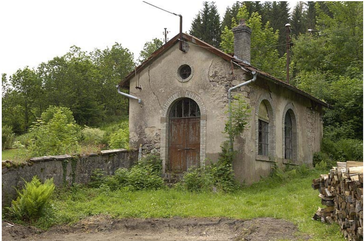
Ancienne centrale hydroélectrique.
