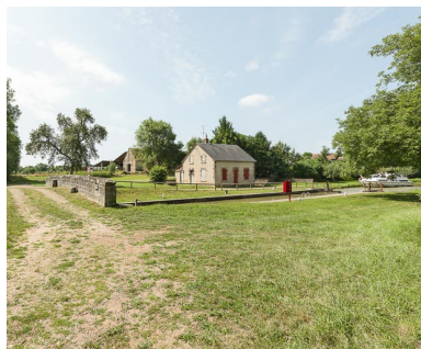
Vue du site d'écluse.
