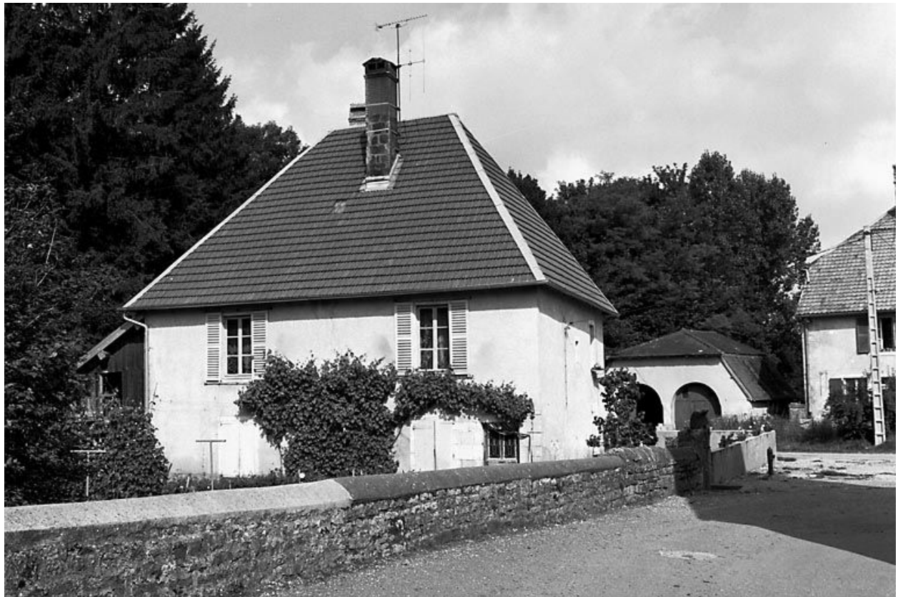
Maison située rue de l'Eglise.
