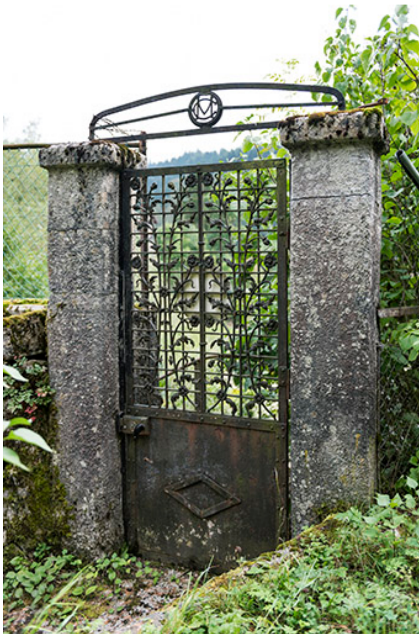
Porte de la clôture, au sud-est.
