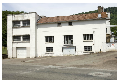
Façade sur la rue de France. Phot. Jérôme Mongreville IVR43_20067000548NUCA
