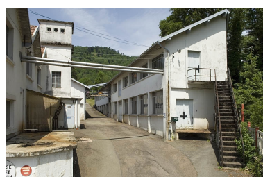
Vue depuis l'entrée. Phot. Jérôme Mongreville IVR43_20067000550NUCA
