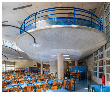
Restauration : salle rez- de-chaussée et mezzanine. Phot. Jérôme Mongreville IVR43_20143900414NUC4A
