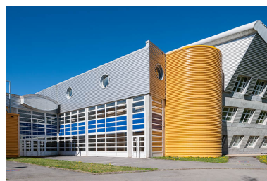
Externat : façade latérale Nord, détail. Phot. Jérôme Mongreville IVR43_20143900383NUC4A
