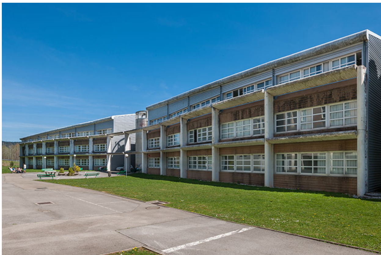
Externat : façades sur rue intérieure, partie Nord.
