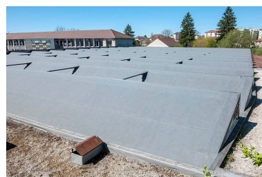
Atelier, site Edouard Herriot, toiture en sheds. Phot. Jérôme Mongreville IVR43_20143900417NUC4A
