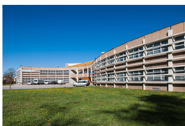
Aministration -restauration : façades antérieures. Phot. Jérôme Mongreville IVR43_20143900392NUC4A
