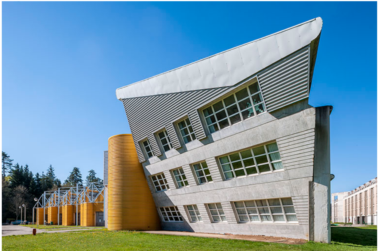
Atelier : façades nord et jonction avec l'externat.
