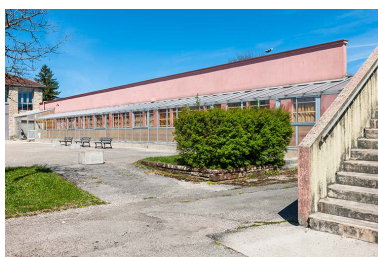
Atelier, site avenue Edouard Herriot : façade antérieure. Phot. Jérôme Mongreville IVR43_20143900416NUC4A
