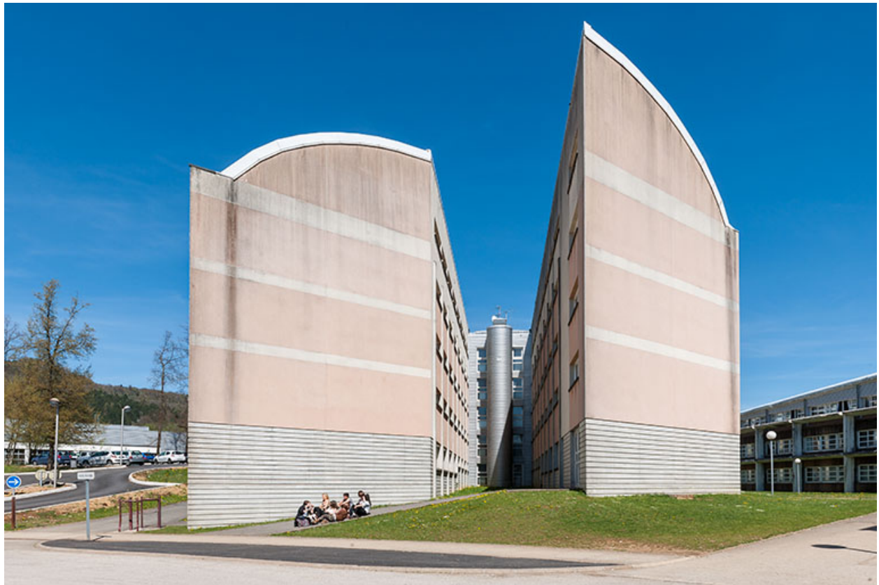
Internat : pignons ouest.
