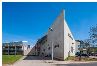
Restauration : façade postérieure et extrémité du bâtiment. Phot. Jérôme Mongreville IVR43_20143900398NUC4A
