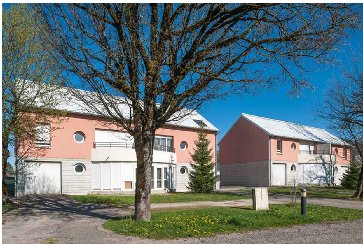
Logements : façades antérieures.
