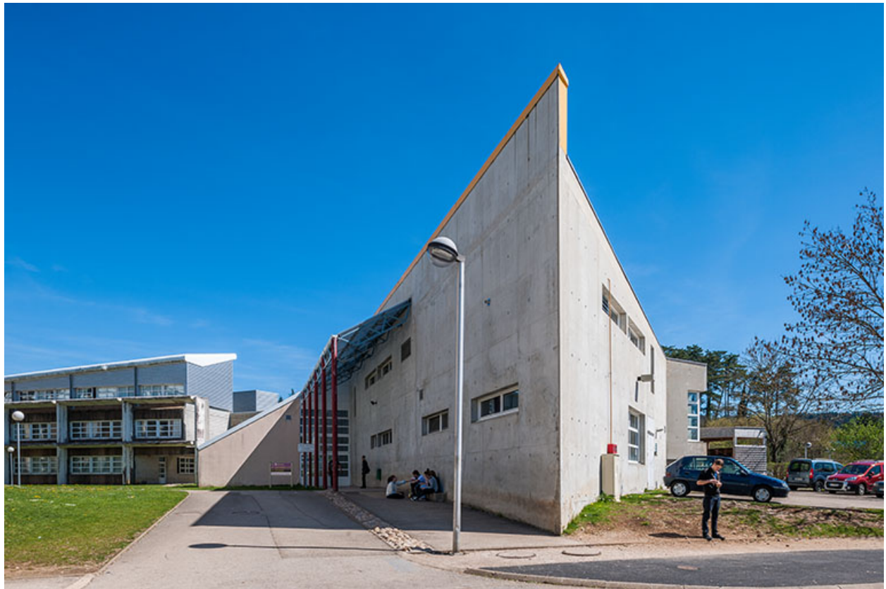
Restauration : façade postérieure et extrémité du bâtiment.
