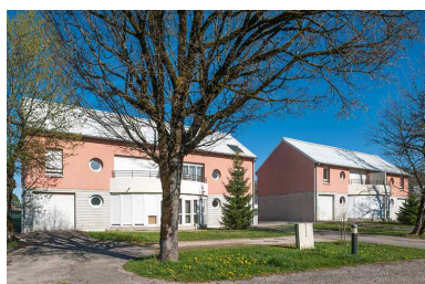
Logements : façades antérieures. Phot. Jérôme Mongreville IVR43_20143900390NUC4A
