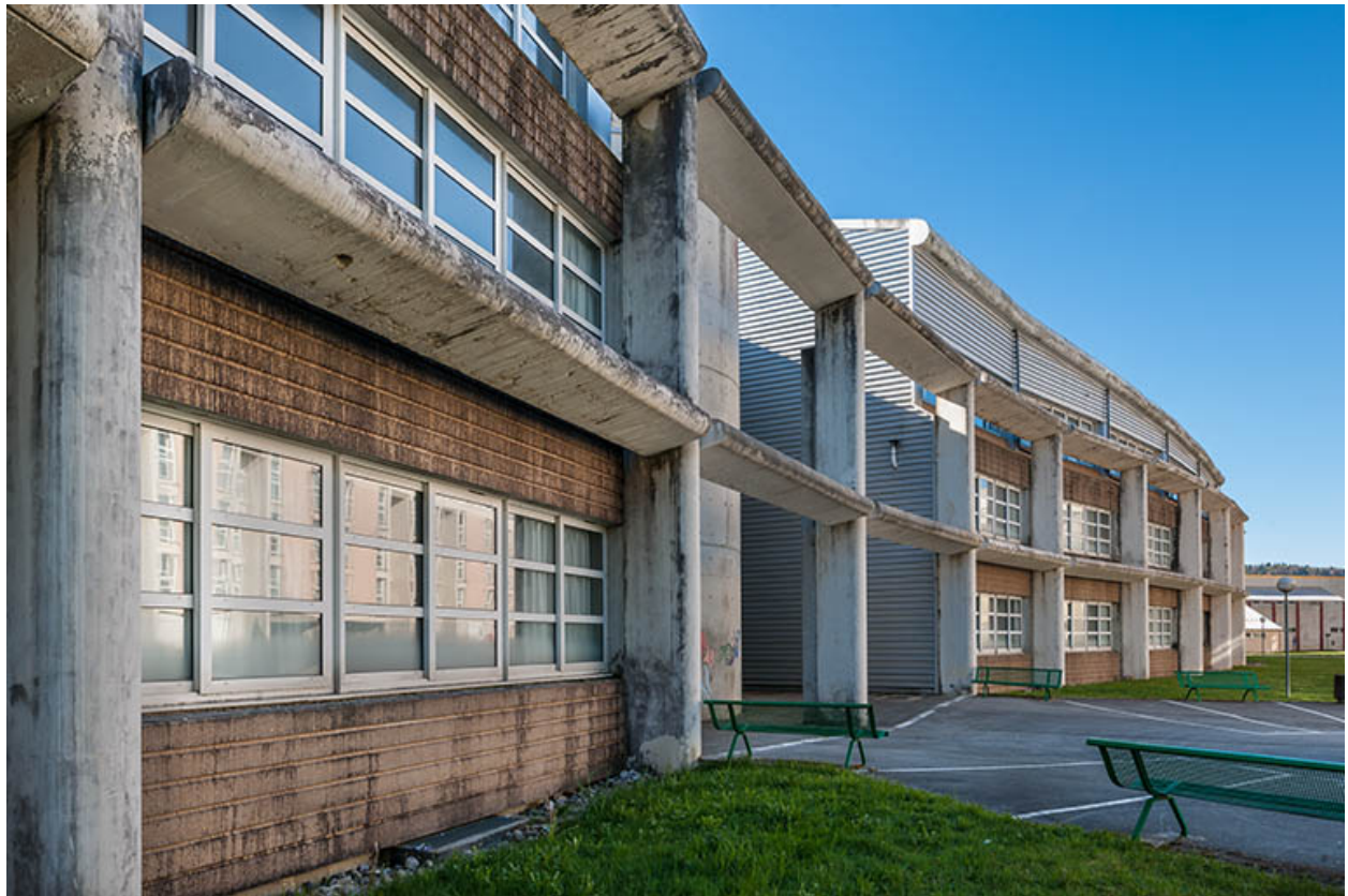
Externat : façades antérieures.
