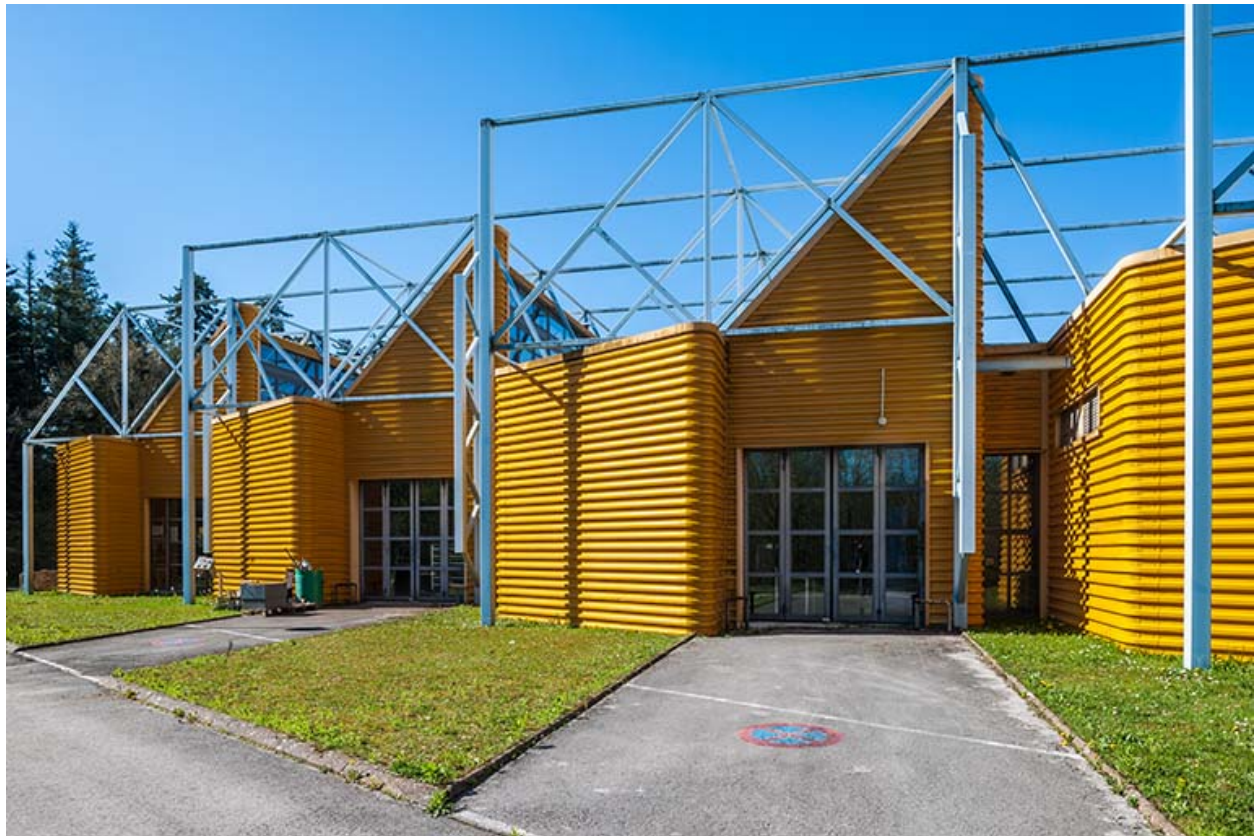
Atelier : ouvertures et matériaux.
