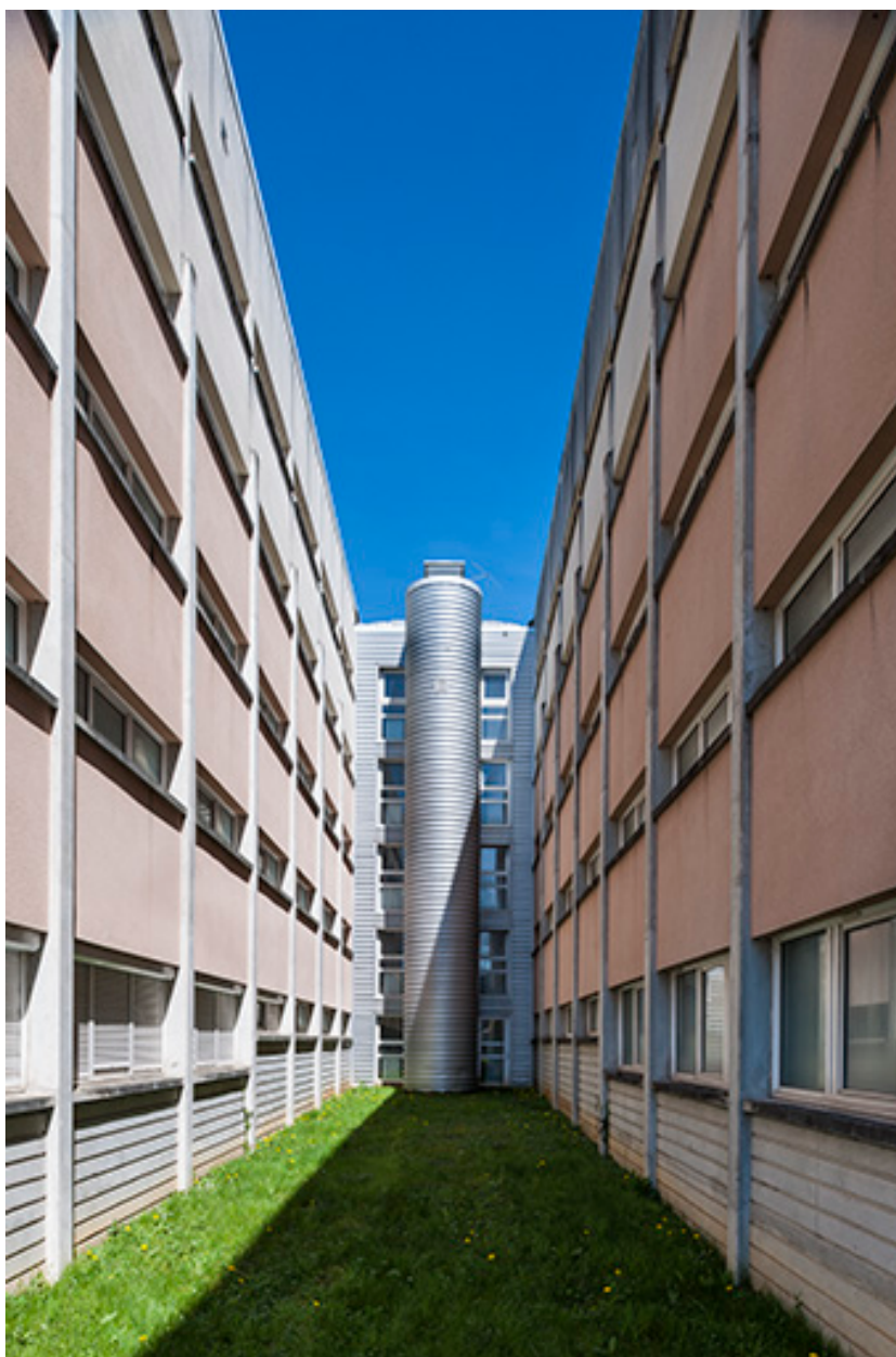
Internat : façades postérieures.
