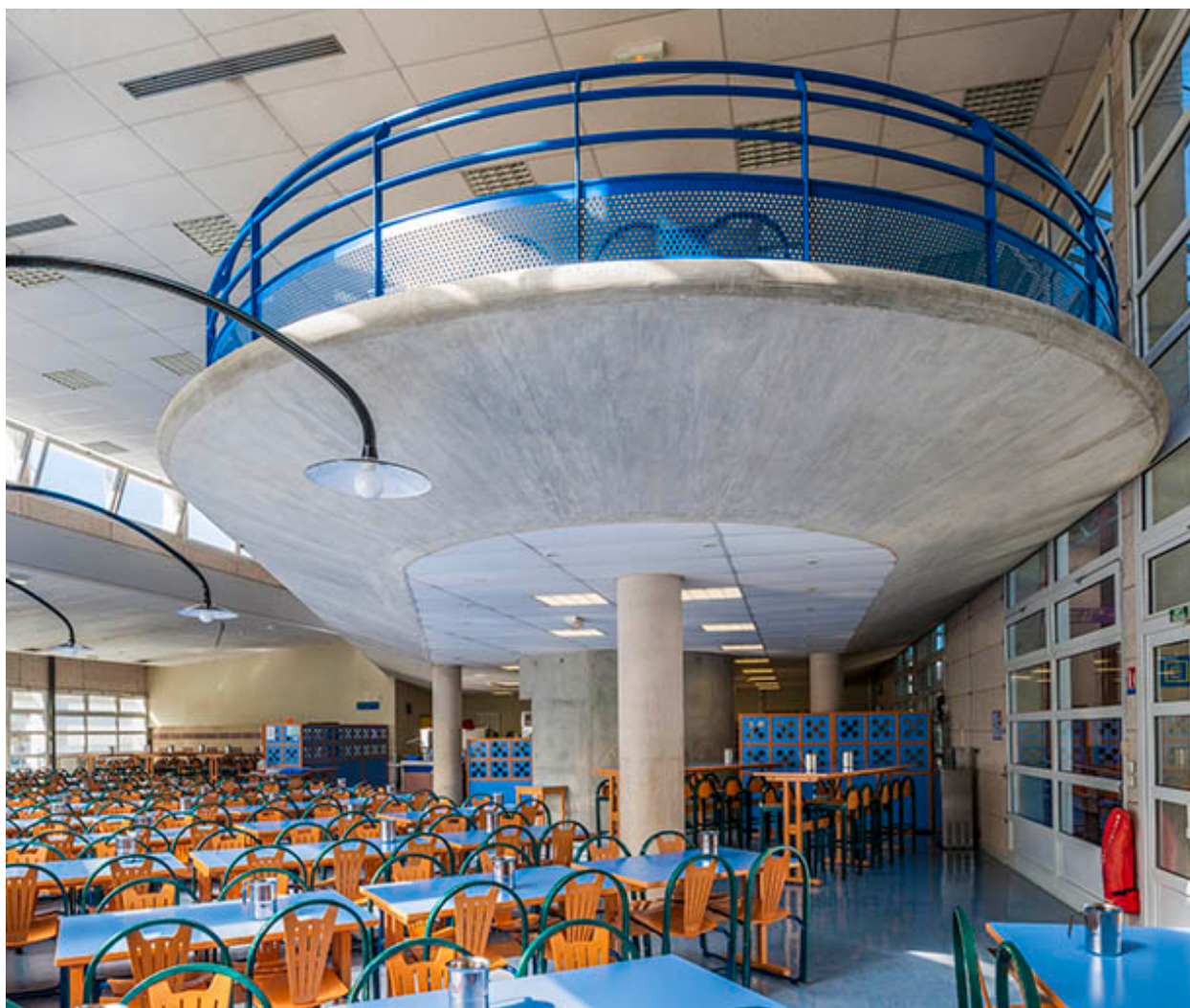
Restauration : salle rez-de-chaussée et mezzanine.
