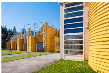
Atelier : façades Nord, détail Phot. Jérôme Mongreville IVR43_20143900382NUC4A
