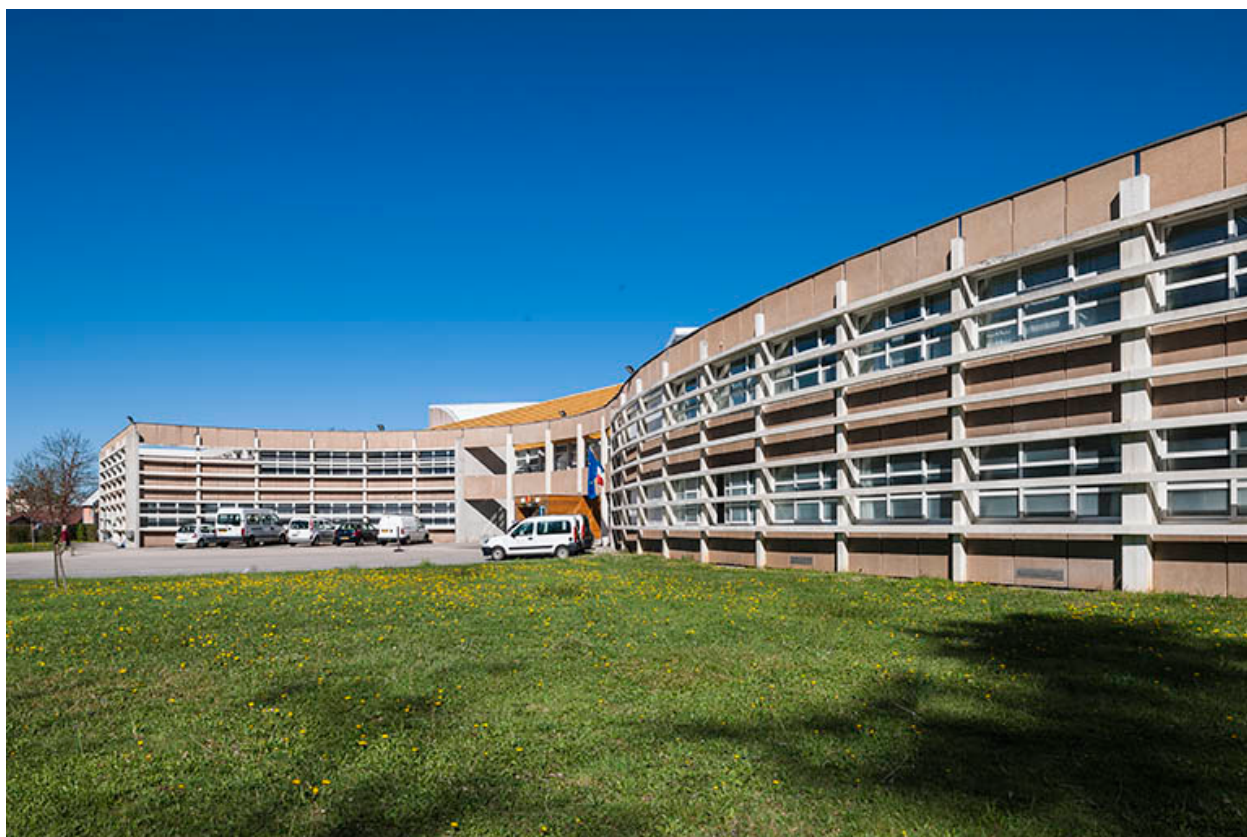
Aministration -restauration : façades antérieures.
