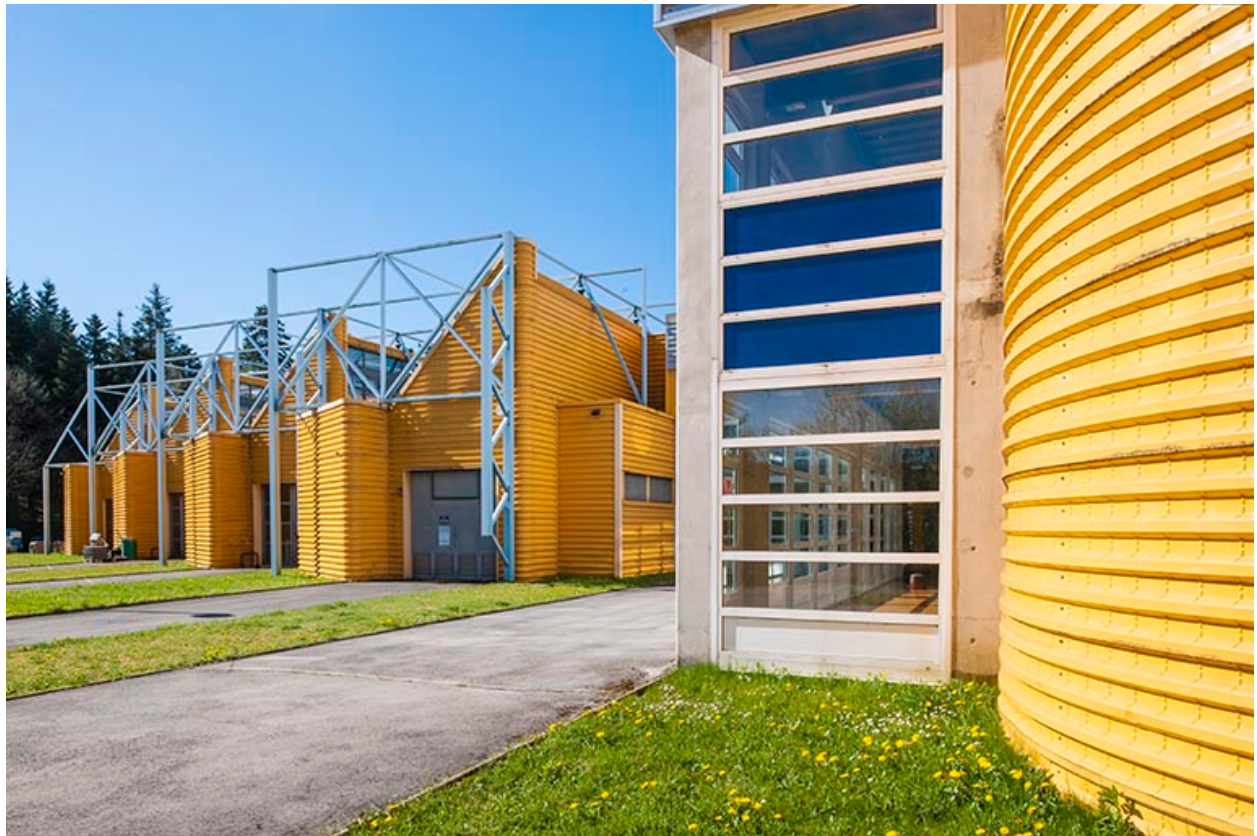
Atelier : façades Nord, détail
