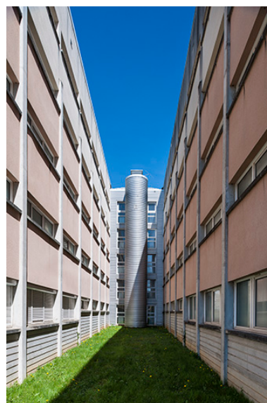
Internat : façades postérieures. Phot. Jérôme Mongreville IVR43_20143900372NUC4A
