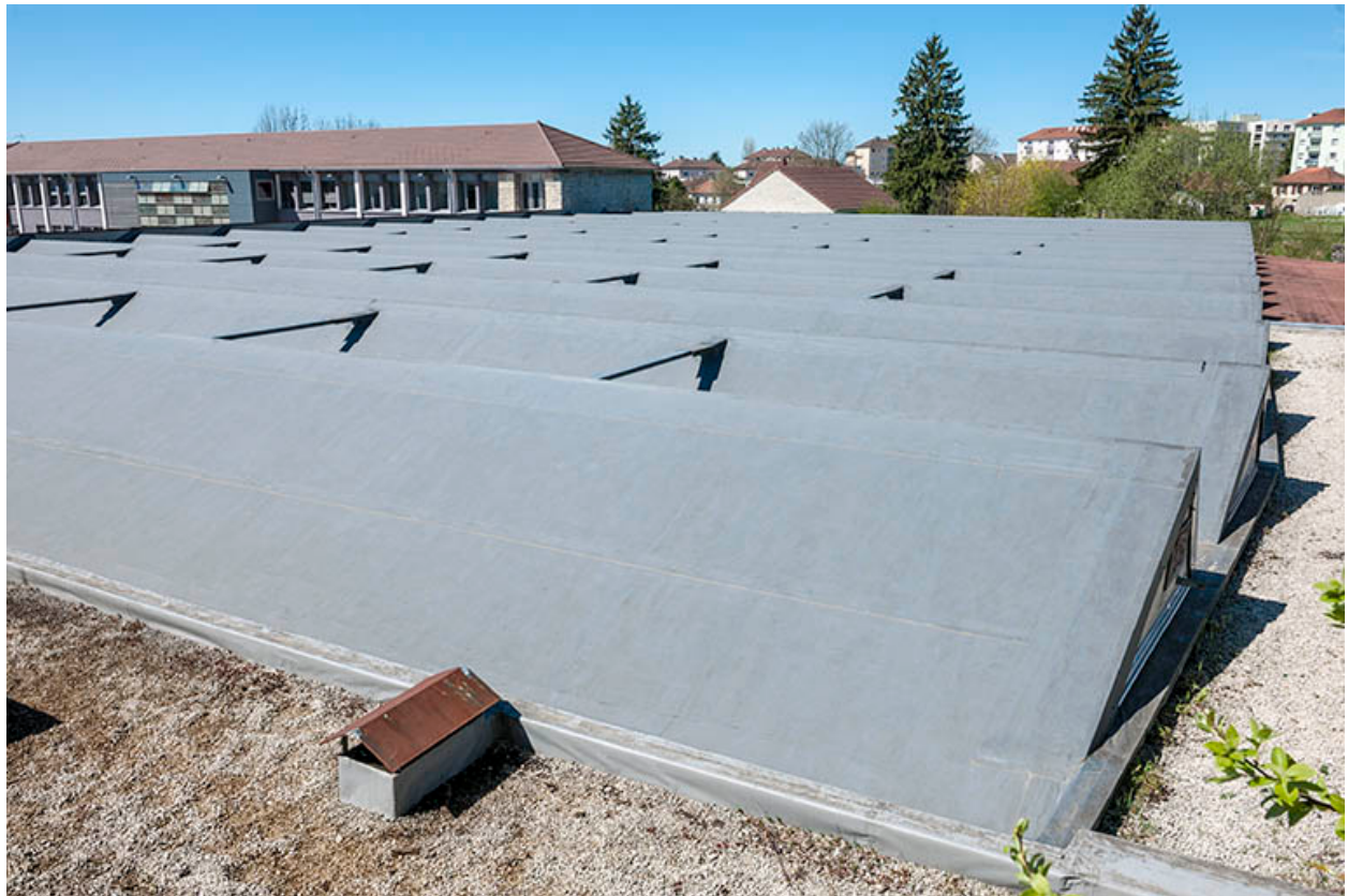
Atelier, site Edouard Herriot, toiture en sheds.
