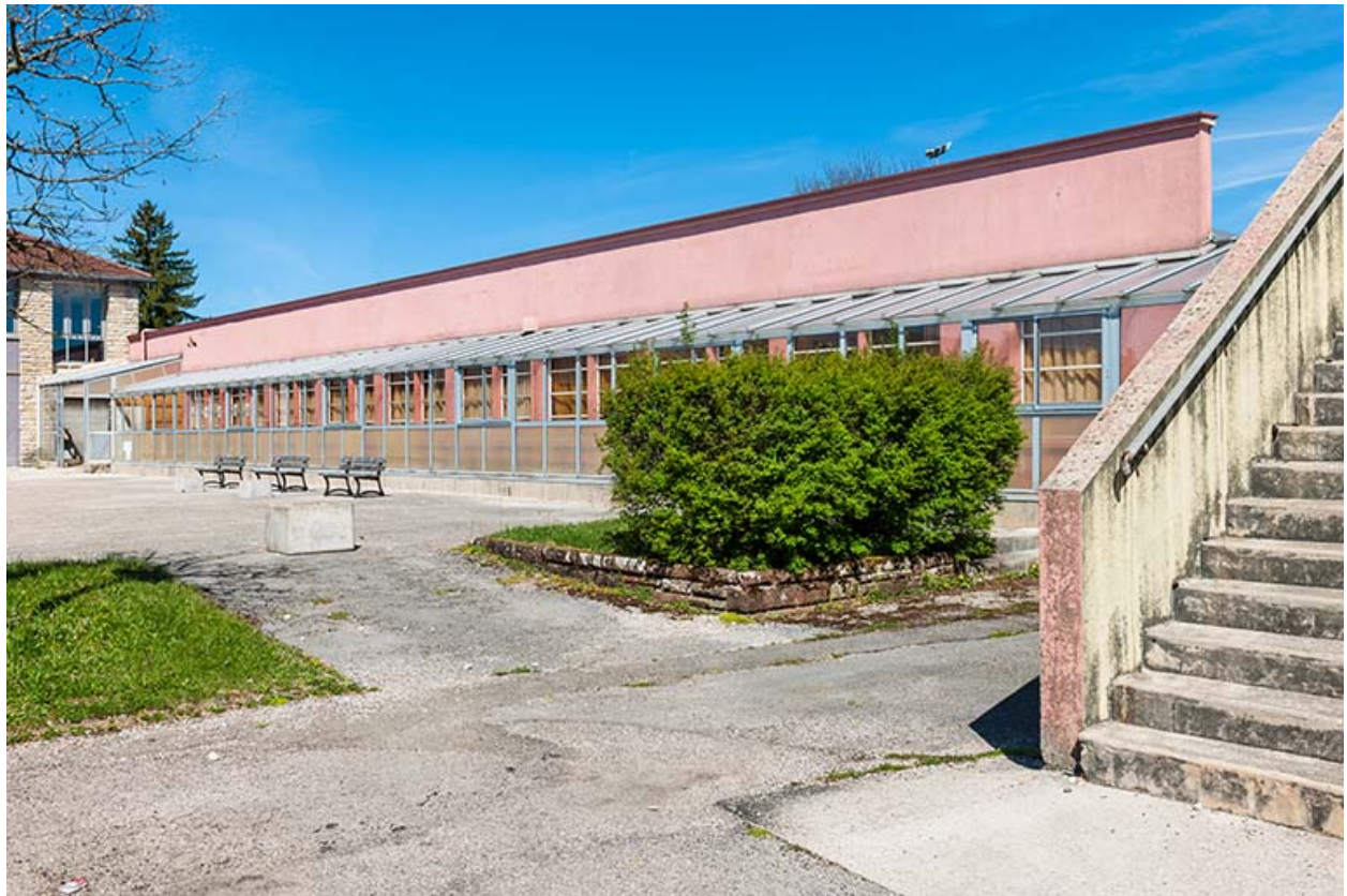
Atelier, site avenue Edouard Herriot : façade antérieure.
