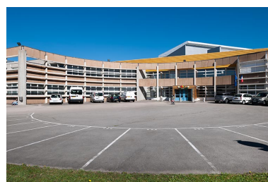
Administration- restauration : accès principal. Phot. Jérôme Mongreville IVR43_20143900393NUC4A
