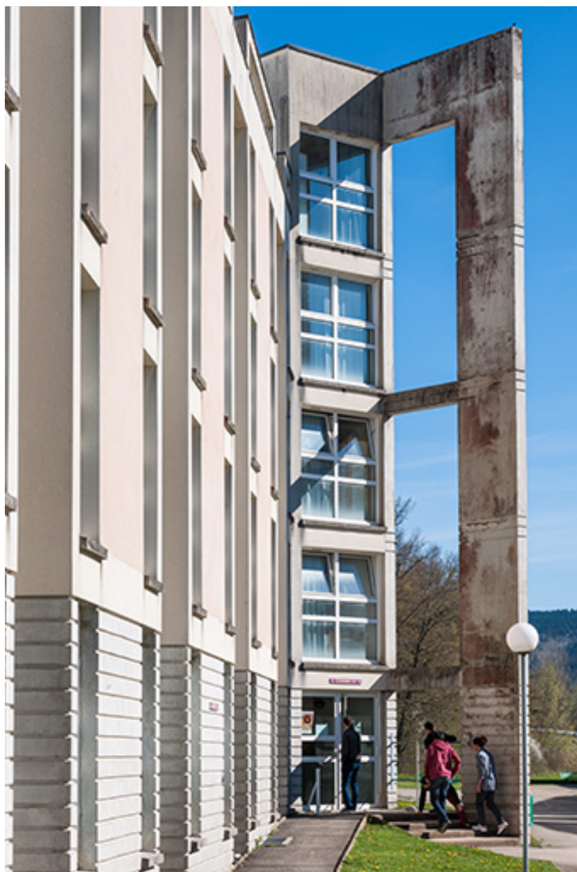
Internat : Détail de la façade antérieure.
