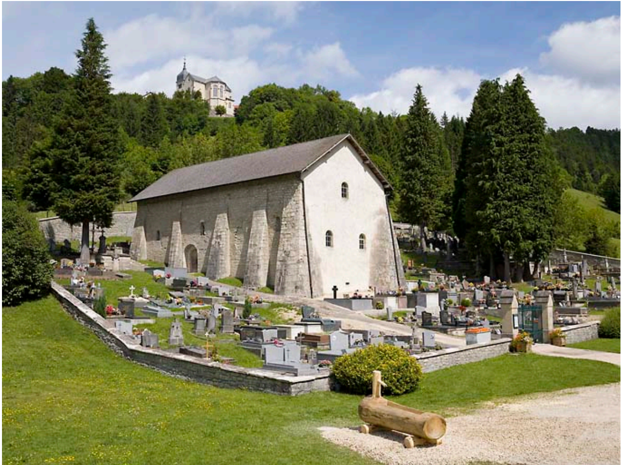
Vue générale, depuis le sud-ouest.
