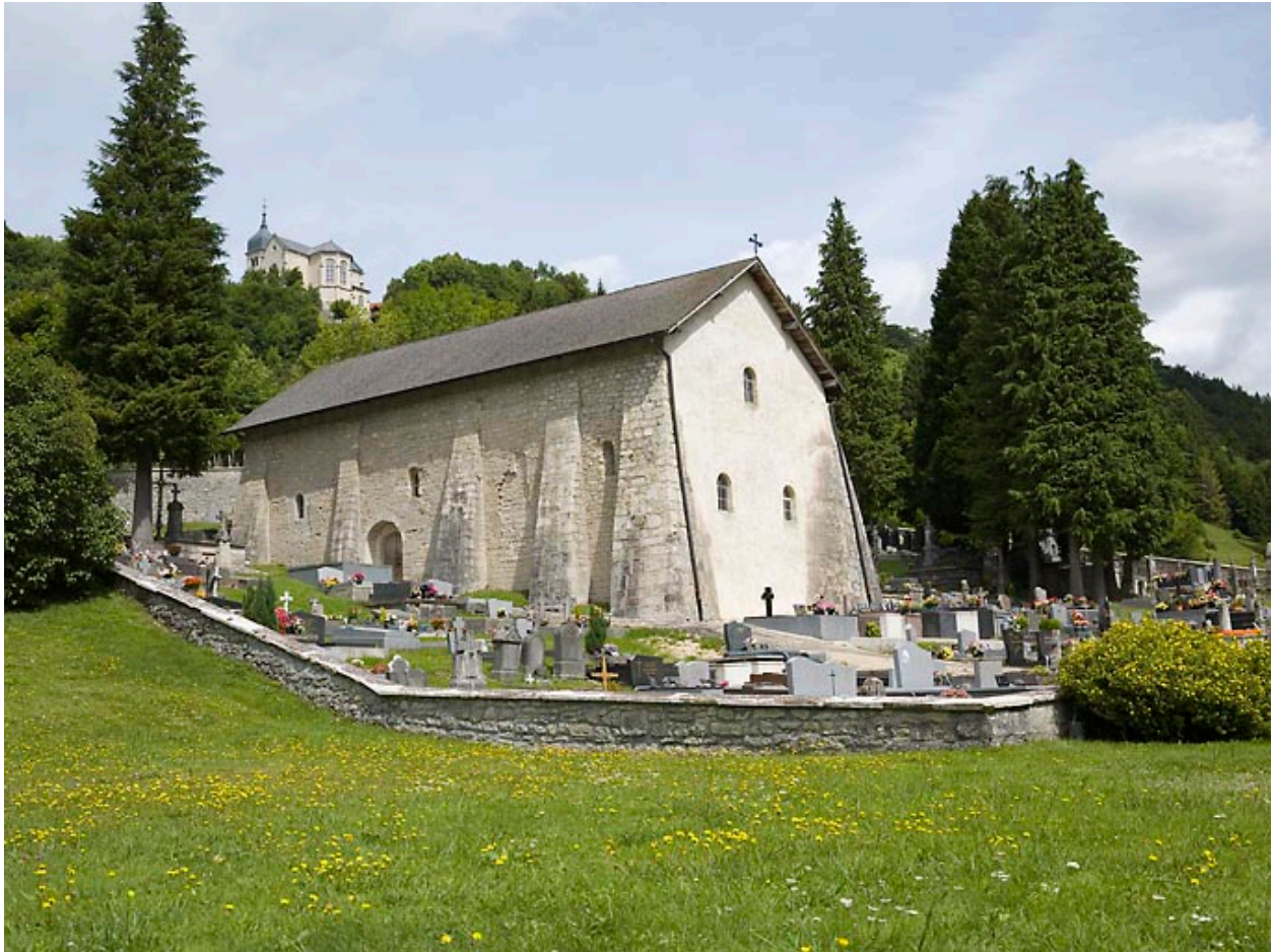
Vue générale, depuis le sud-ouest.
