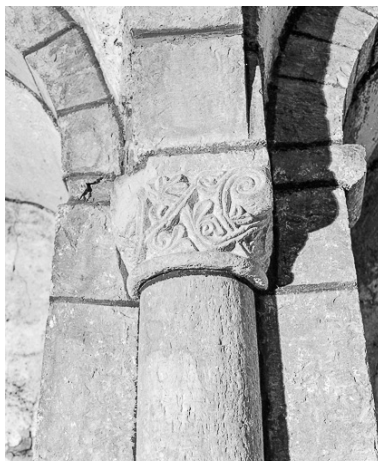
Crypte : chapiteau du mur ouest, côté nord. Phot. Yves Sancey IVR43_19792500484X
