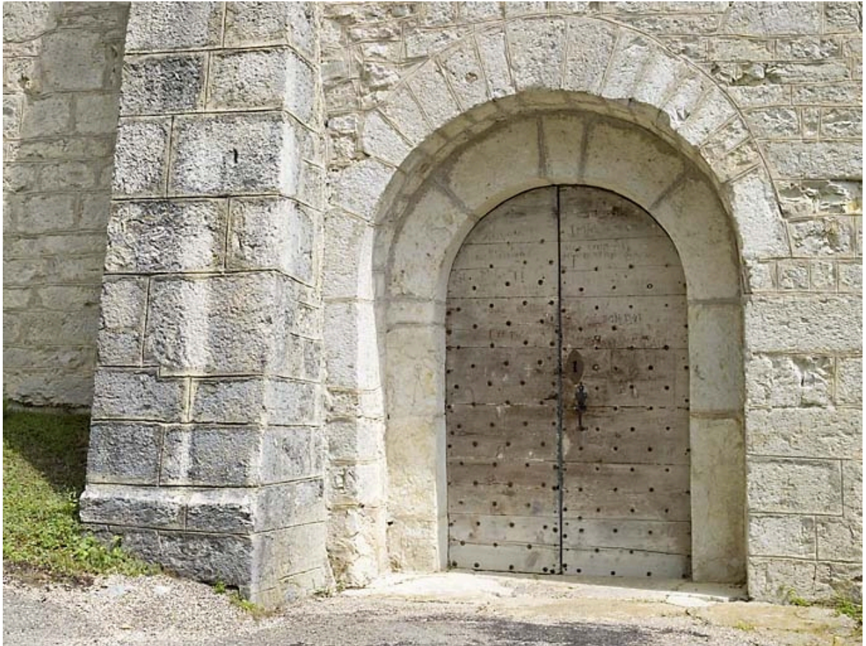
Façade sud : entrée.
