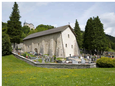
Vue générale, depuis le sud-ouest. Phot. Jérôme Mongreville IVR43_20082500658NUC2A
