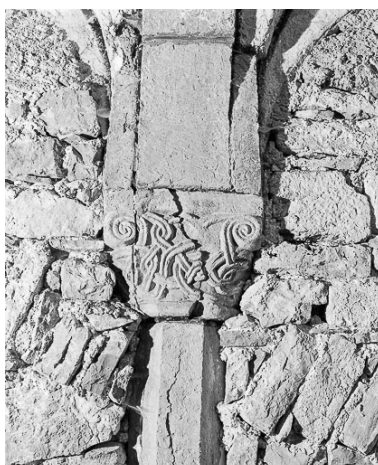
Crypte : chapiteau du mur est, côté nord. Phot. Yves Sancey IVR43_19792500480X
