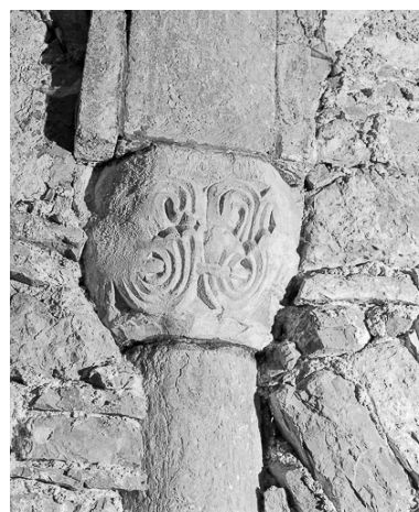
Crypte : chapiteau du mur est, côté sud. Phot. Yves Sancey IVR43_19792500481X
