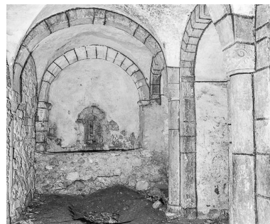
Vue d'ensemble de la crypte. Phot. Yves Sancey IVR43_19792500479X
