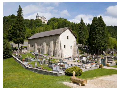
Vue générale, depuis le sud-ouest. Phot. Jérôme Mongreville IVR43_20082500657NUC2A
