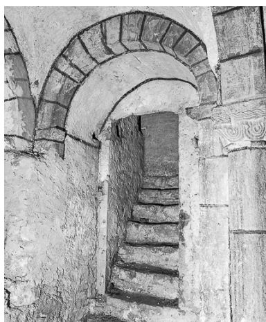
Crypte : escalier menant à la nef. Phot. Yves Sancey IVR43_19792500482X
