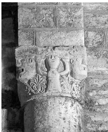
Intérieur : détail du chapiteau avec un personnage. Phot. Yves Sancey IVR43_19792500477X
