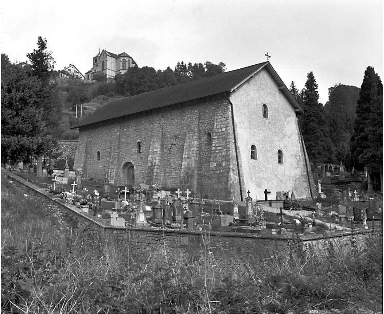
Façades sud et est.
