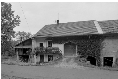
Ferme située au lieu-dit Samiat : façade antérieure. Phot. Jérôme Mongreville IVR43_19943901171X
