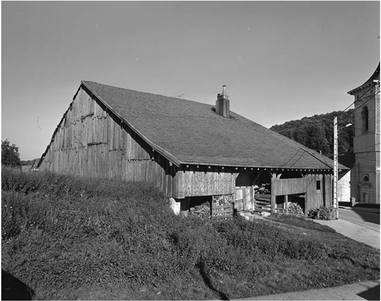
Façades postérieure et latérale gauche.
