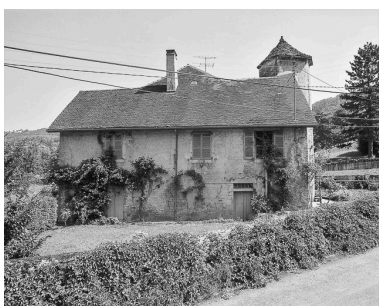
Façade postérieure. Phot. Yves Sancey IVR43_19843900333X
