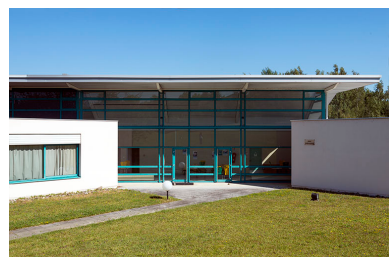
Détail façades sud des bâtiments de plasturgie.(ex-Léger)
