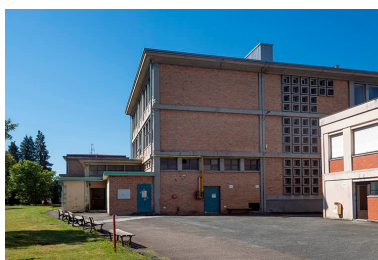
Façades antérieures (nord) du bâtiment d'externat. (ex-Garnier) Phot. Mary Ruffinoni IVR43_20142500653NUC4A
