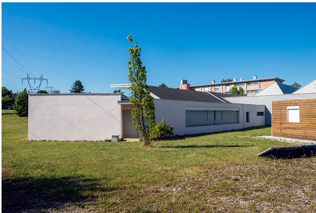
Façade postérieure nord de la plasturgie. (ex-Léger)
