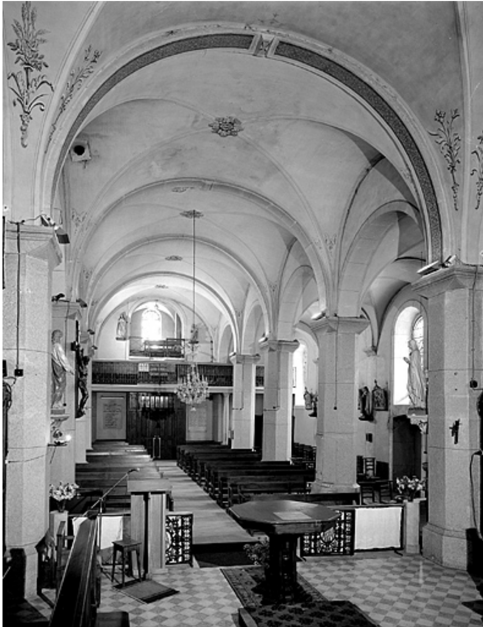
Elévation intérieure nord de la nef, vue depuis le chœur.
