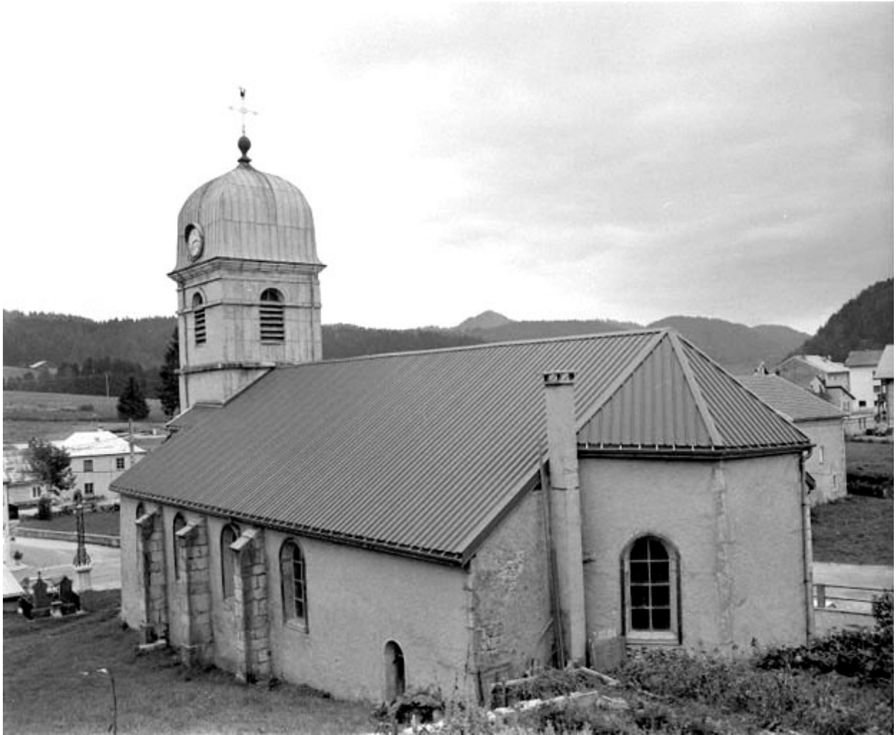
Extérieur : l'abside vue de trois quarts.
