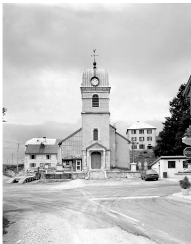
Extérieur : façade occidentale. Phot. Yves Sancey IVR43_19943900949V
