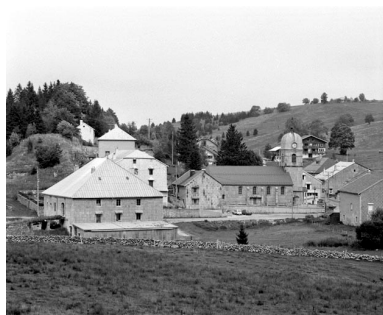
Extérieur : vue de situation depuis le nord-est. Phot. Yves Sancey IVR43_19943900954X
