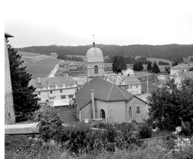
Extérieur : l'abside vue de face. Phot. Yves Sancey IVR43_19943900958X
