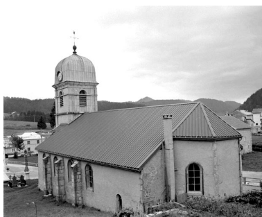
Extérieur : l'abside vue de trois quarts. Phot. Yves Sancey IVR43_19943900957X
