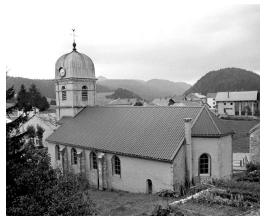
Extérieur : face sud et abside. Phot. Yves Sancey IVR43_19943900956X
