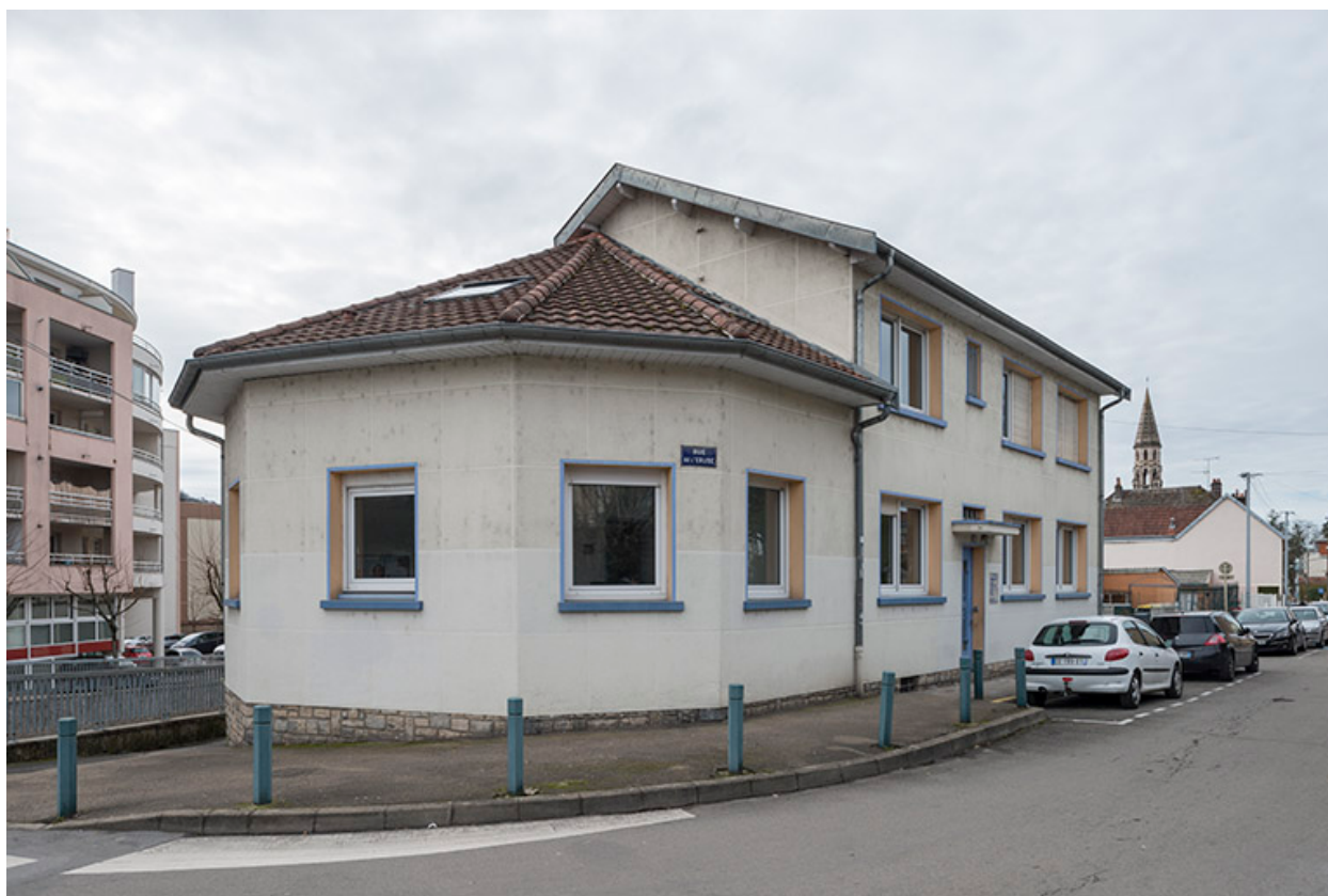
Vue depuis le nord.
