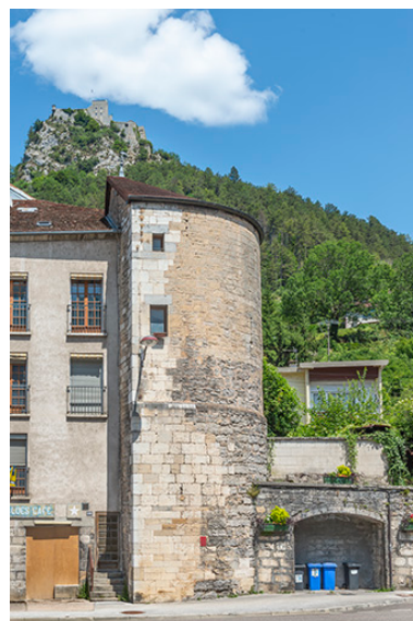
Fort Belin et tour Oudin. Phot. Jérôme Mongreville IVR43_20233900960NUC4A
