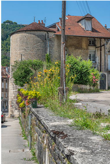
Tour et maison attenante à l'est. Phot. Jérôme Mongreville IVR43_20233900986NUC4A
