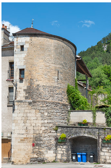
Vue rapprochée depuis l'ouest.
