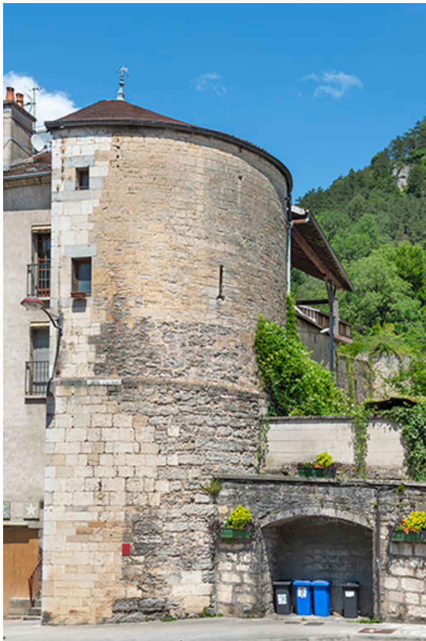
Vue rapprochée depuis l'ouest.
