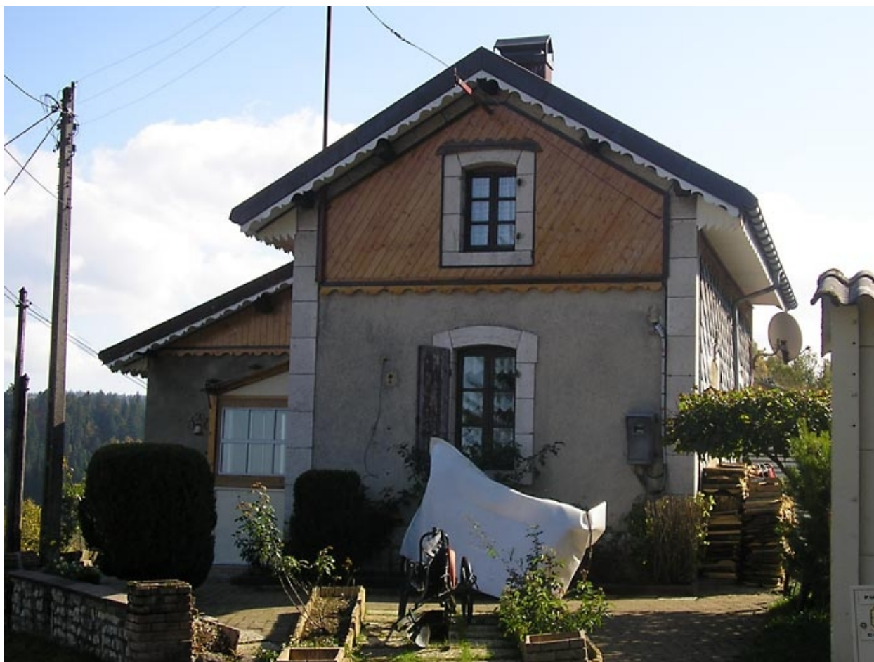
Vue latérale de la façade ouest.
