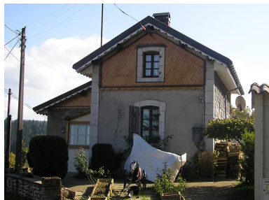
Vue latérale de la façade ouest.
