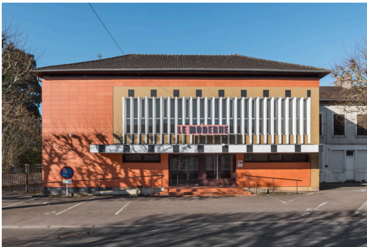
Corps d'entrée : façade antérieure.
