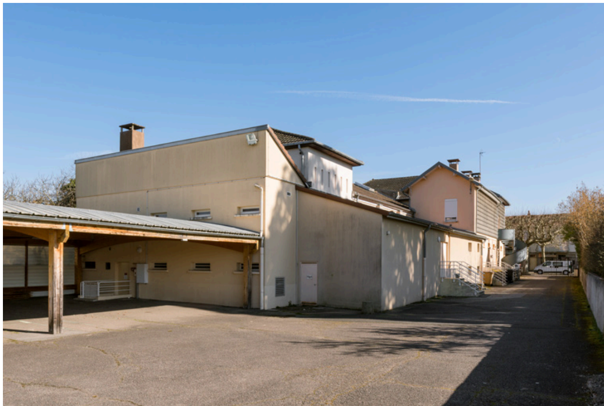
Vue d'ensemble, depuis les garages au sud-ouest.
