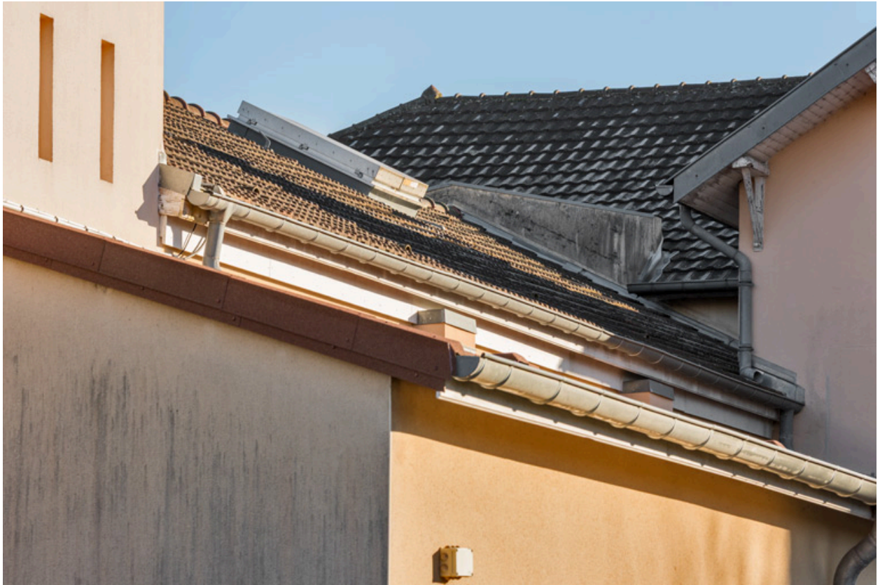
Toitures et ancien mur écran du Modern Cinéma.
