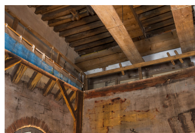
Machinerie : gril et palettes pour la fixation des fils. Phot. Pierre-Marie Barbe-Richaud IVR26_20257101079NUC4A
