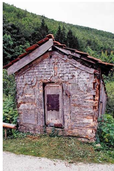
Resserre appelée aussi "grenier fort".
