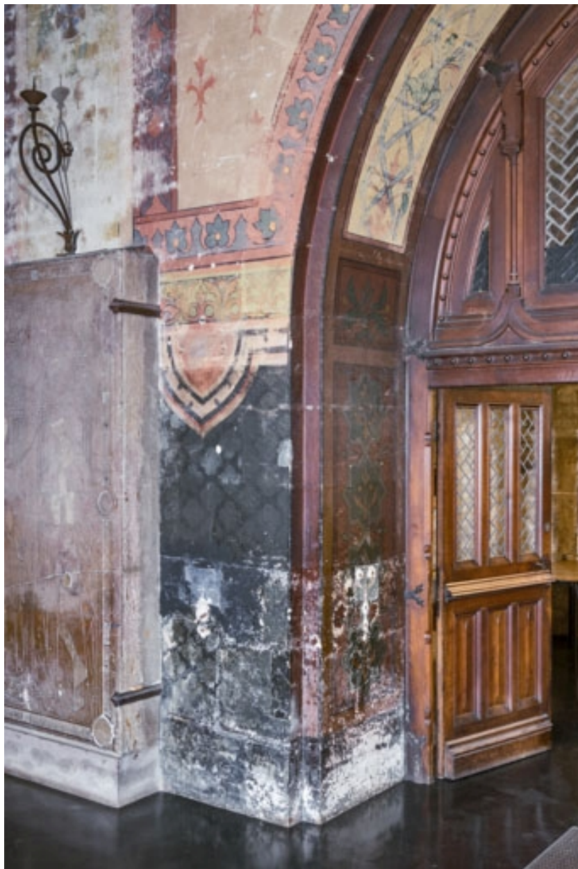
Décor peint en partie basse du mur sud.
