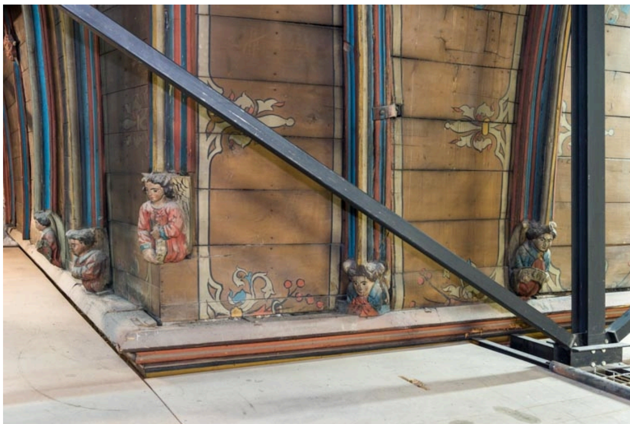
Anges : rondes-bosses ornant les arcs des fausses-voûtes de la croisée du transept (dans l'angle sud-est).
