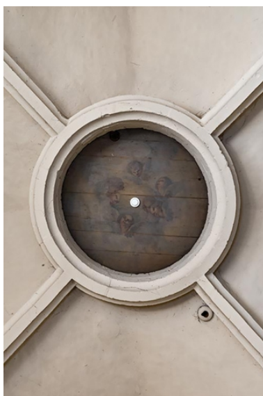
Angelots peints sur le couvercle de l'ouverture zénithale, ancienne chapelle du Saint-Sépulcre (rez- de-chaussée de la tour sud).
