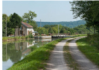
Vue du site d'écluse depuis l'amont. Phot. Pierre-Marie Barbe-Richaud IVR26_20112103773NUC4AQ
