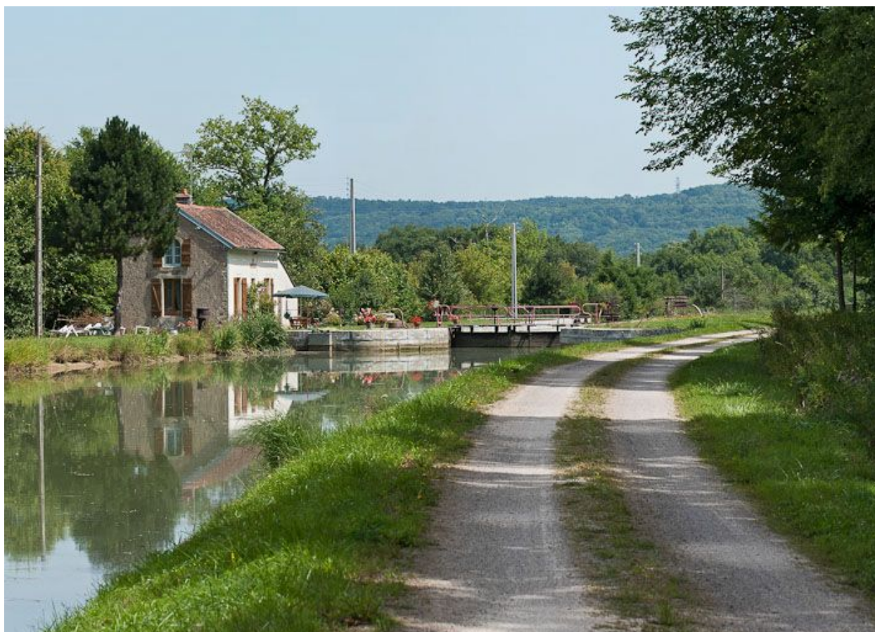
Vue du site d'écluse depuis l'amont.
