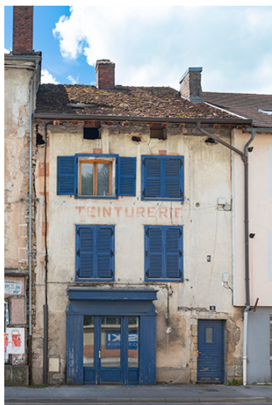
Façade sur rue. Phot. Jérôme Mongreville IVR43_20243900672NUC4A
