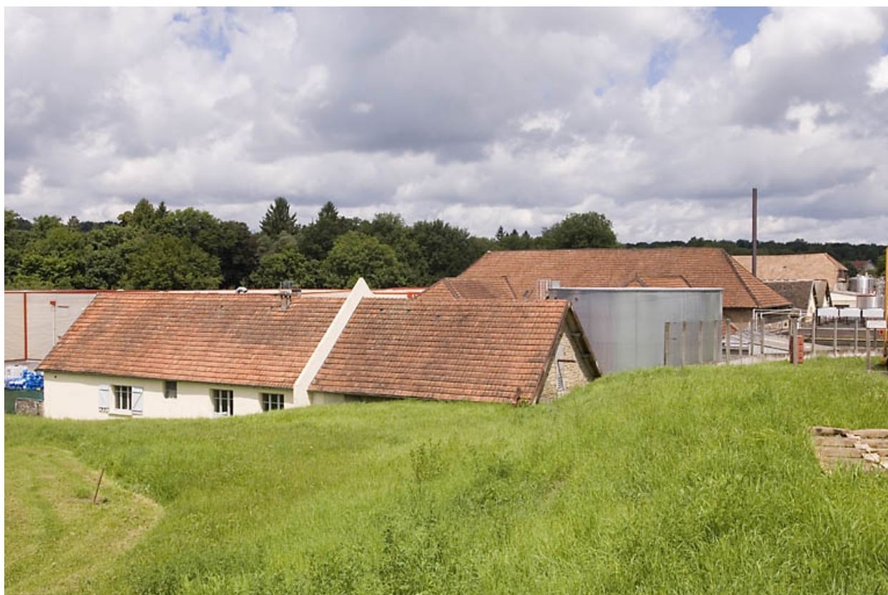
Vue sur les toitures depuis le sud-est.
