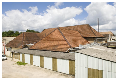
Halle de fonderie depuis le sud-est. Phot. Jérôme Mongreville IVR43_20087000744NUC2A
