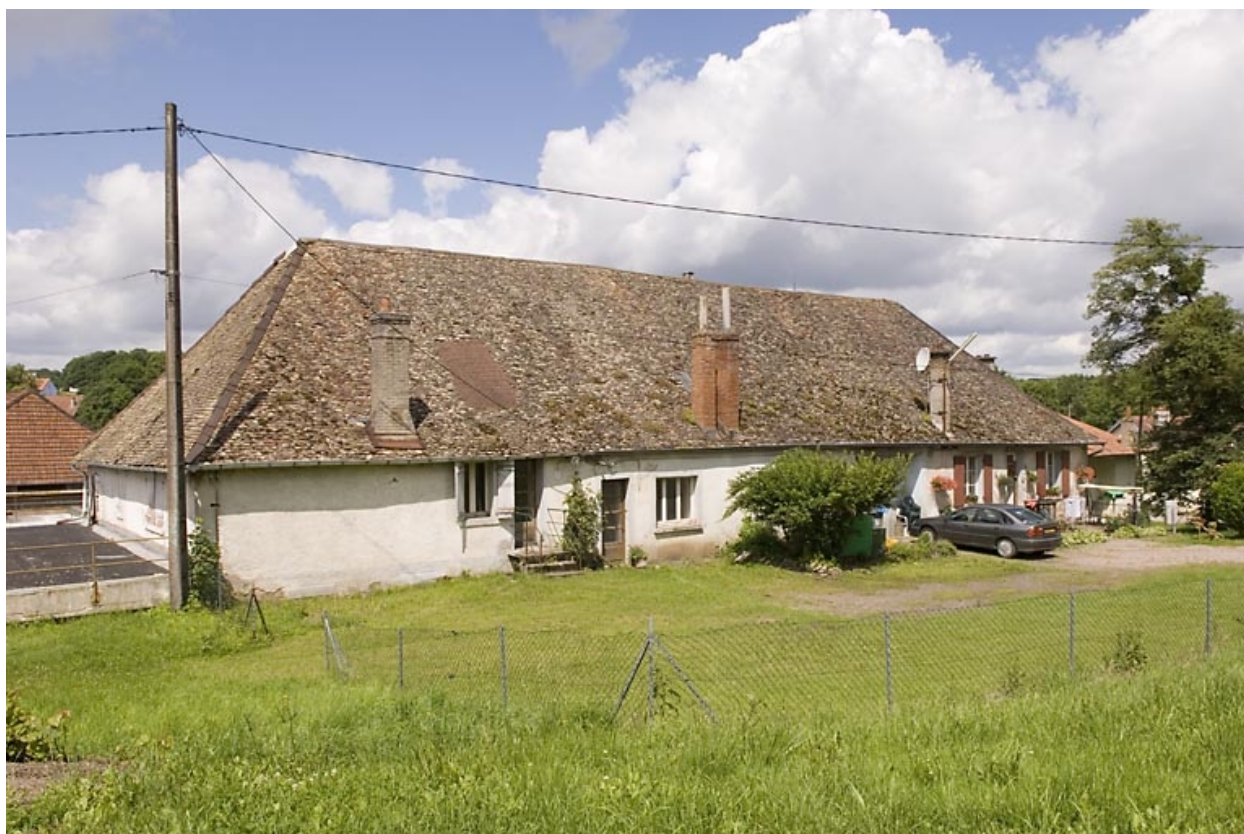
Logement ouvrier depuis l'est.
