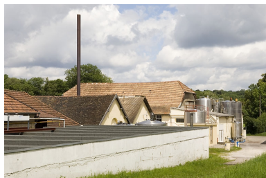
Vue arrière des bâtiments industriels. Phot. Jérôme Mongreville IVR43_20087000745NUC2A
